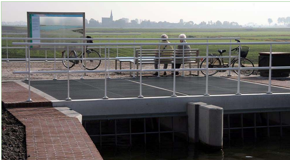
Waterinlaat calamiteitenberging met 't Woudt op de achtergrond
