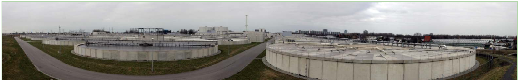
Afvalwaterzuiveringsinstallatie (AWZI) in de Harnaschpolder
