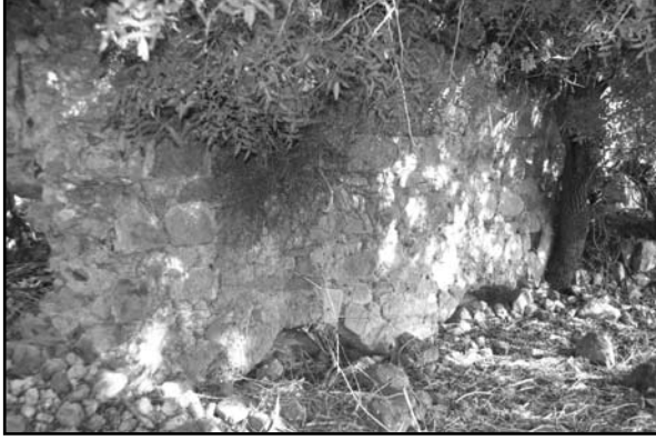
Resim 10: Hamamın (?) dođu duvarındaki k3r niřler
