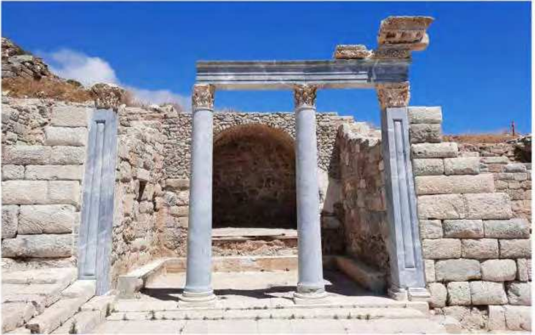
Resim 14: Liman Caddesi Heroon 'u koruma ve onarım çalışmaları sonrası görünümü.
