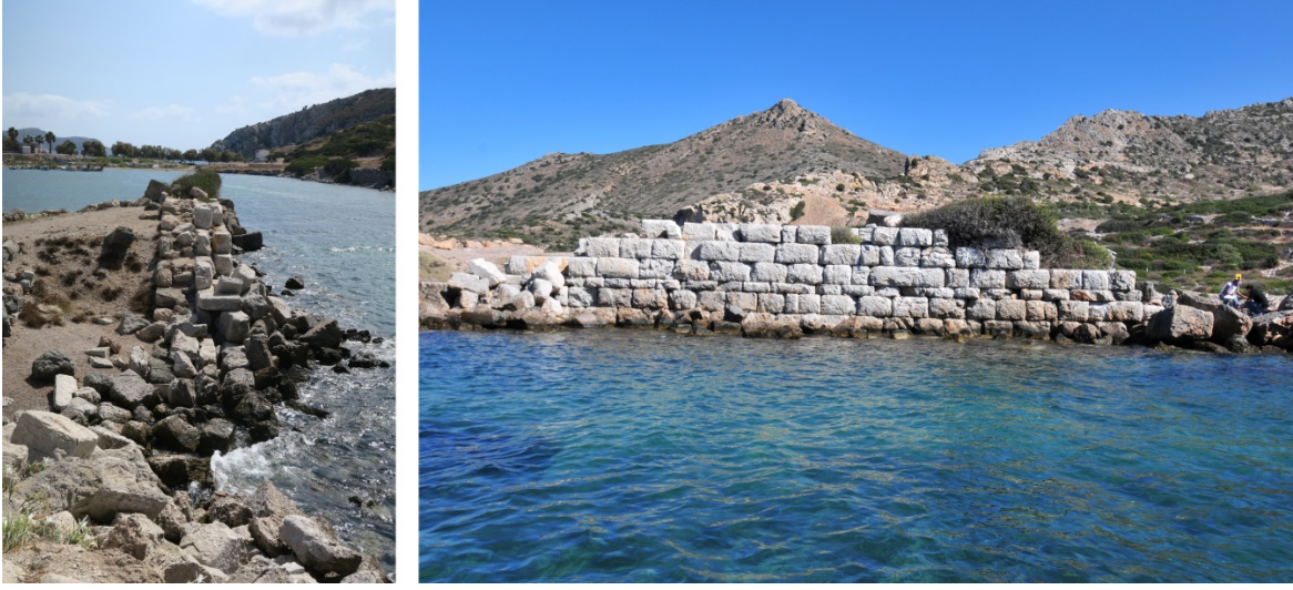
Fig. 18. Askeri Liman Mendireği Güney Duvarı.
