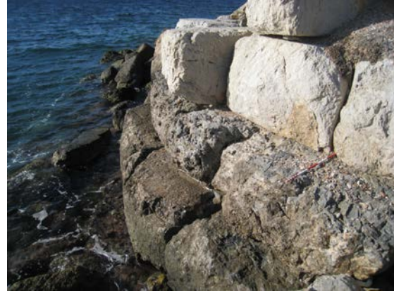
Fig. 14. Yuvarlak Kule 2 İki kademeli Alt Yapı.
