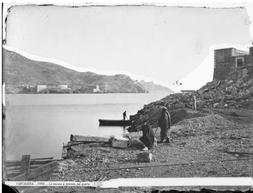
Fig. 12 - Fotografía de 1870 de las obras en la Punta de Navidad. Laurent.
