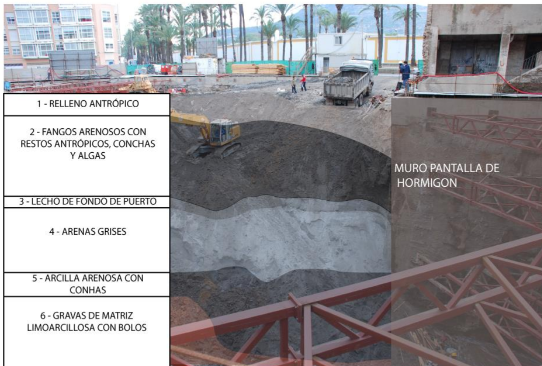
Fig. 179 - Foto de la obra de la Plaza del Par del perfil suroeste.
