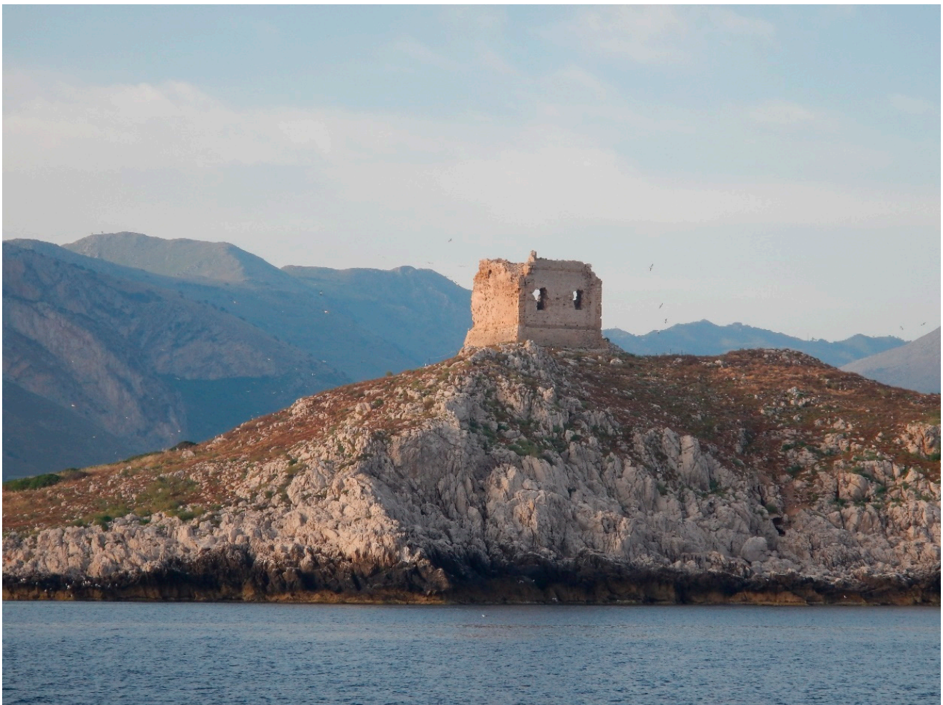
Figure 24. Isola delle Femmine (PA): the Sea Tower, view from north (Photo G. Bucci).
