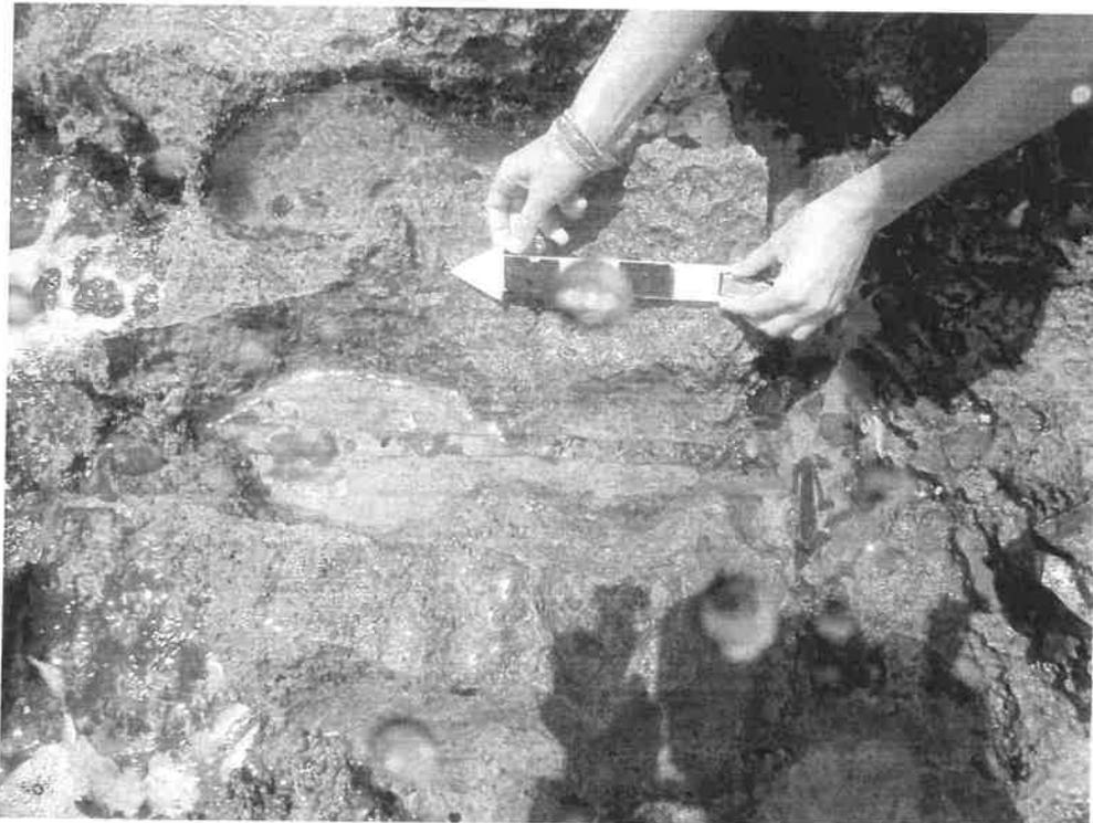
Fig. 2 - Vestiges de joint servant à lier les blocs de ramleh du «Môle» st1016.
