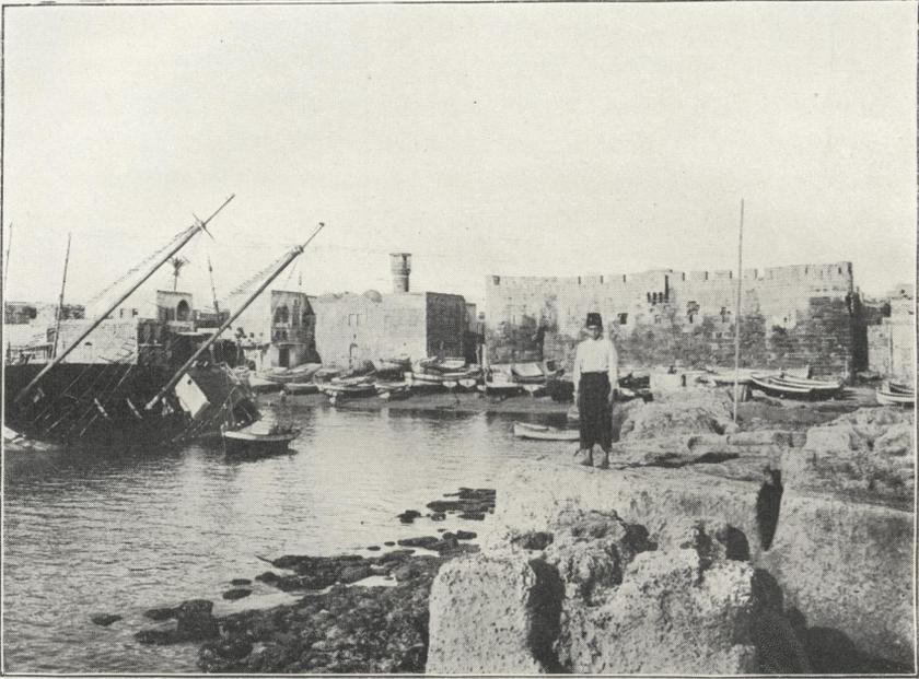
Fig. 4. — Digue exhaussée par une assise de gros blocs entre les deux havres de Rouad.
