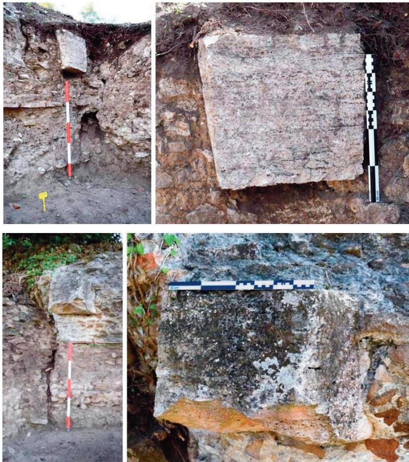
Fig. 6 – Bloques de travertino en los ángulos de la cabeza del muelle (© Grupo Vrbanitas).
