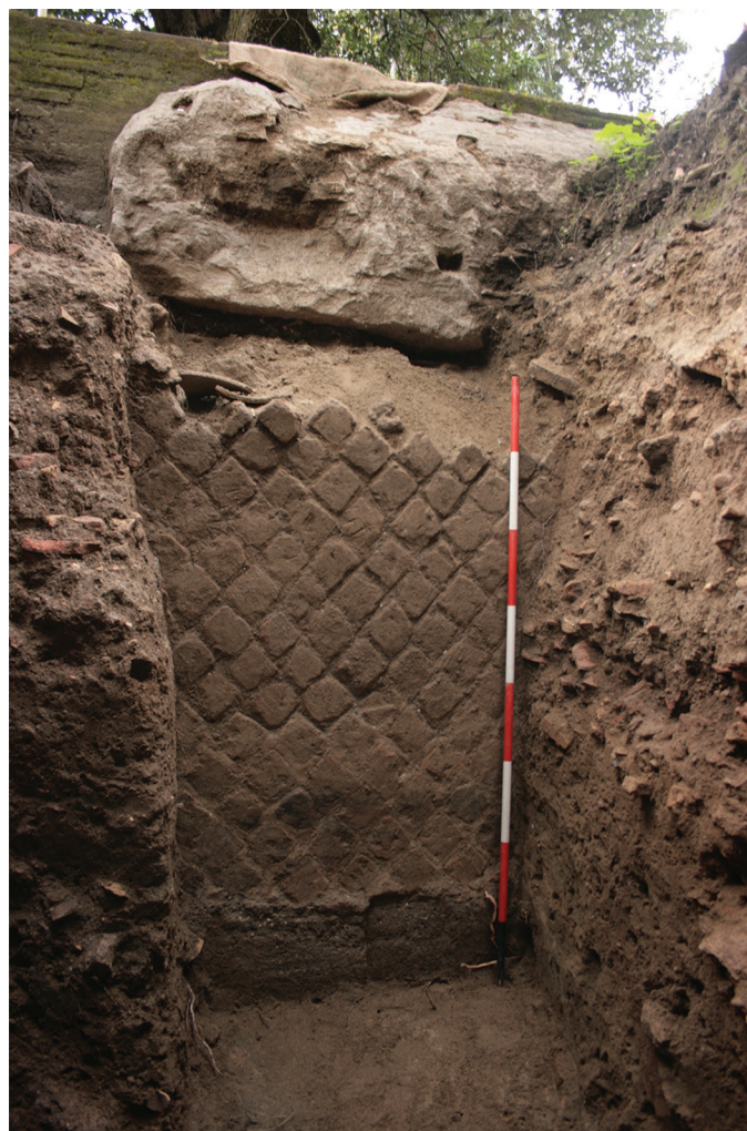
Fig. 3 – Mise au jour du système de fondation claudien dans le secteur C des entrepôts dits de Trajan (cliché E. Bukowiecki @EFR).
