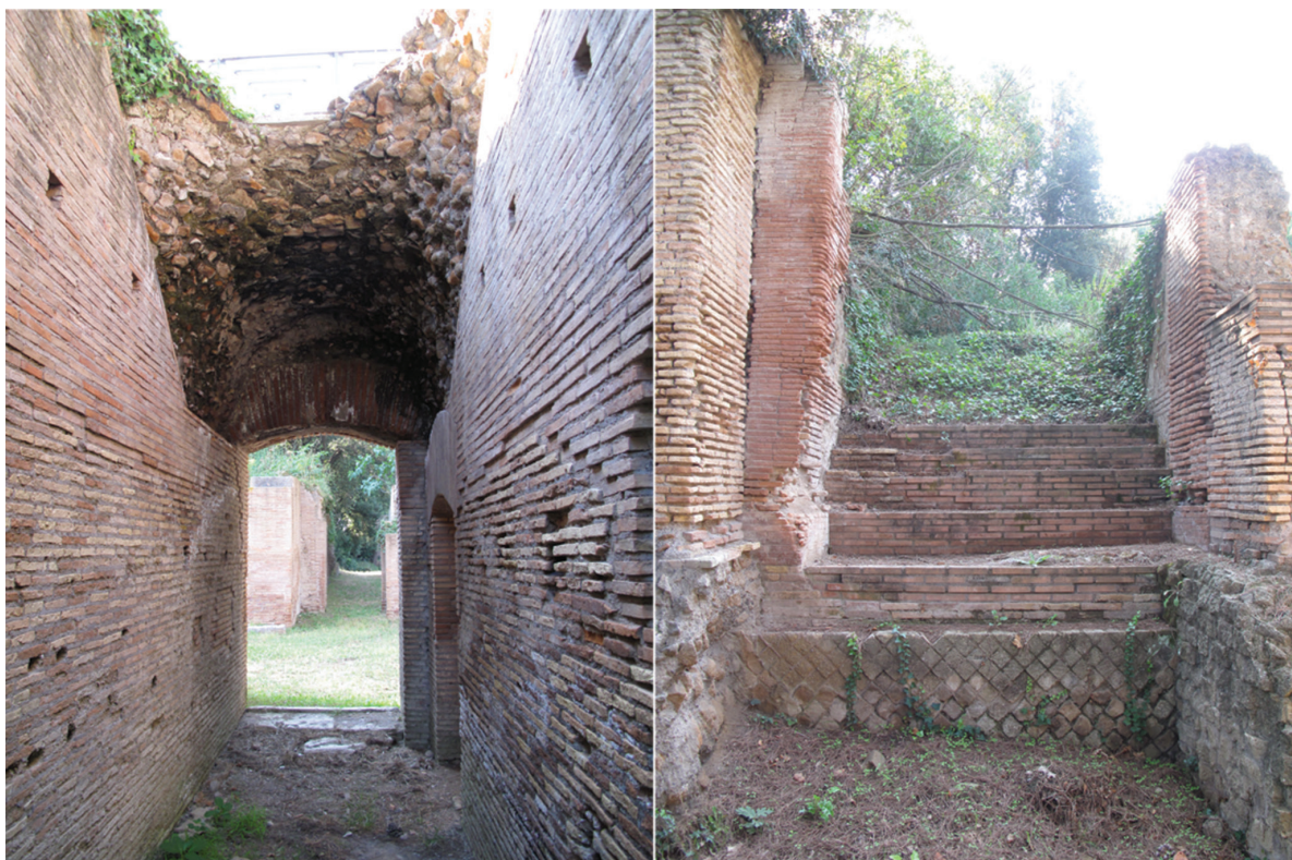
Fig. 7 – Exemple d'un passage transversal et d'une rampe d'accès à l'étage des corps de fabrique transversaux (clichés Ch.-E. Sauvin @EFR/Centre des Monuments Nationaux).
