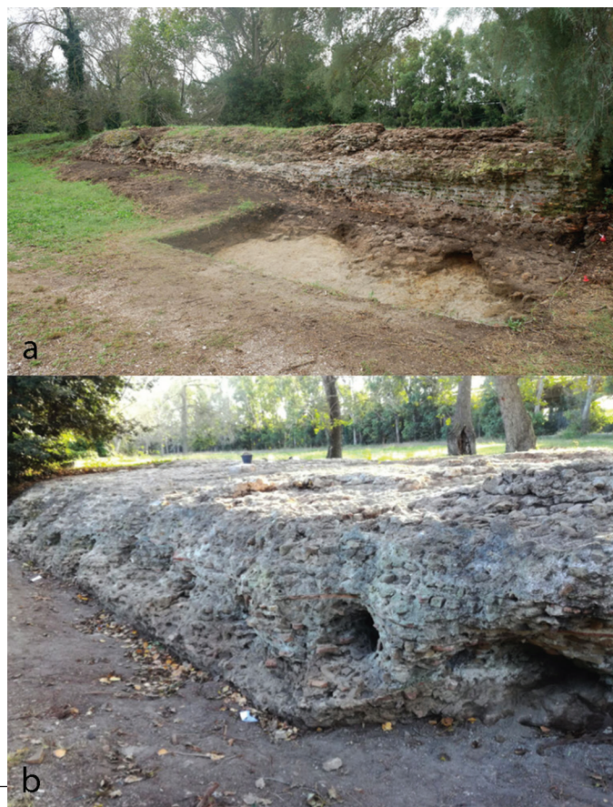
Fig. 12 – a- Restauration sévérienne de l'élévation du môle de Claude et structures tardives qui s'adossent à la façade portuaire de l'extrémité nord de ce môle ; b- Elévation de l'extension sévérienne du môle de Claude (clichés R. Fabro @EFR/ Arkod-Lugdunum).
