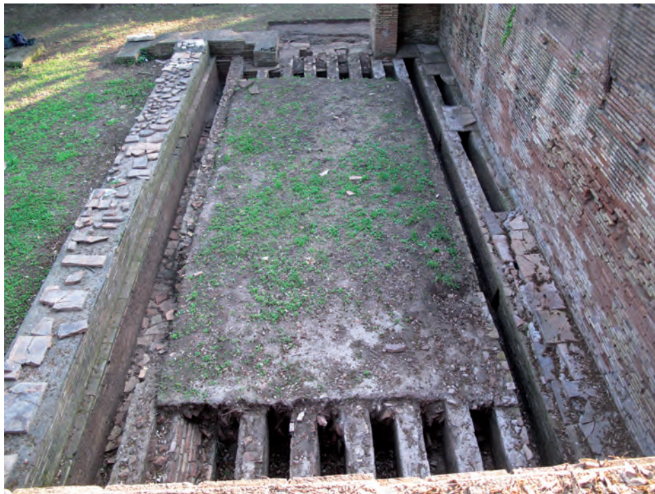
Fig. 10 — Vue vers l'ouest de la cellule F47 à la fin de son dégagement partiel (cl. Ch.-É. Sauvin).
