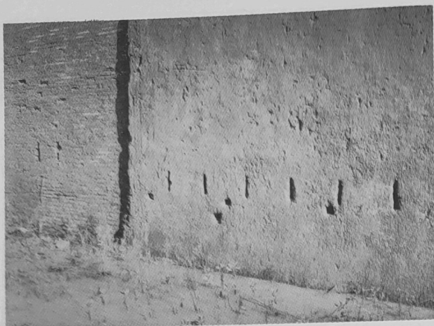
Fig. 6. Porto di Claudio, Monte Giulio: rivestimento interno della cisterna a grosso cocciopisto liscio; incavi per il posizionamento di supporti lignei di servizio e tracce di graffiti.
