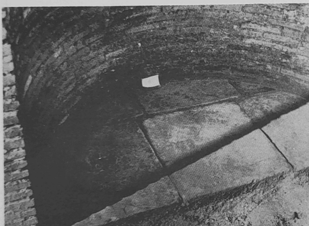
Fig. 8. Porto di Claudio, Monte Giulio: cisterna lato est, nicchia con dettaglio della pavimentazione a bipedali bollati.
