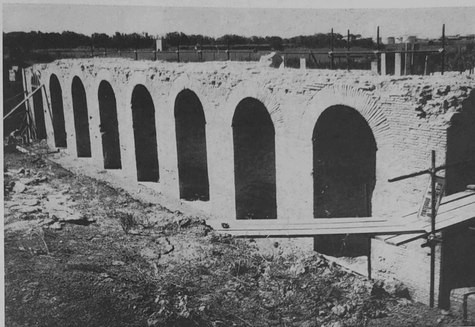
Fig. 4. Porto di Claudio, Monte Giulio: scavo e messa in luce della cisterna: lato orientale.
