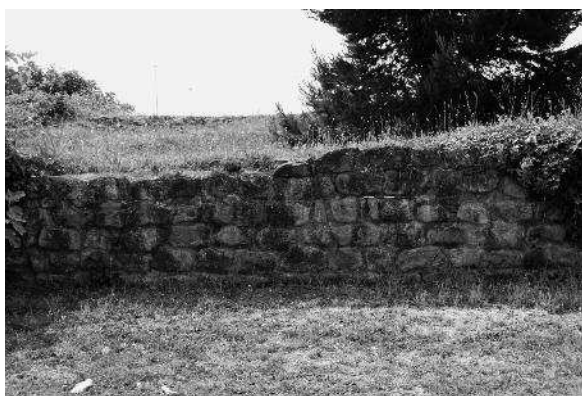
Fig. 20. Portus: porto di Claudio, troncone B, lato nord; particolare del paramento in conci di tufo.
