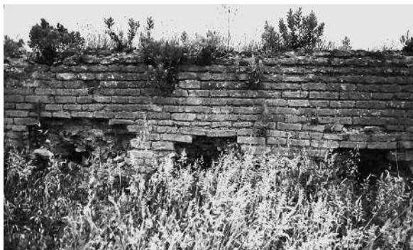
Fig. 22. Portus: porto di Claudio, troncone B, lato nord; paramento in testaceo (1985).
