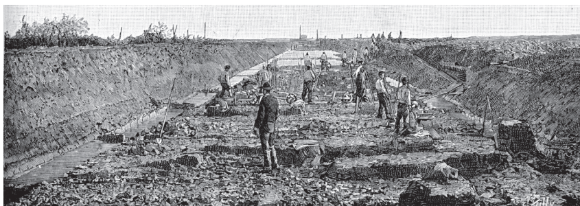
Creusement d'un canal de drainage du marais de Fos en 1890 / Scavo di un canale di drenaggio per le paludi di Fos nel 1890 ( Le magasin pittoresque , vol. 58, 1890, p. 217).
