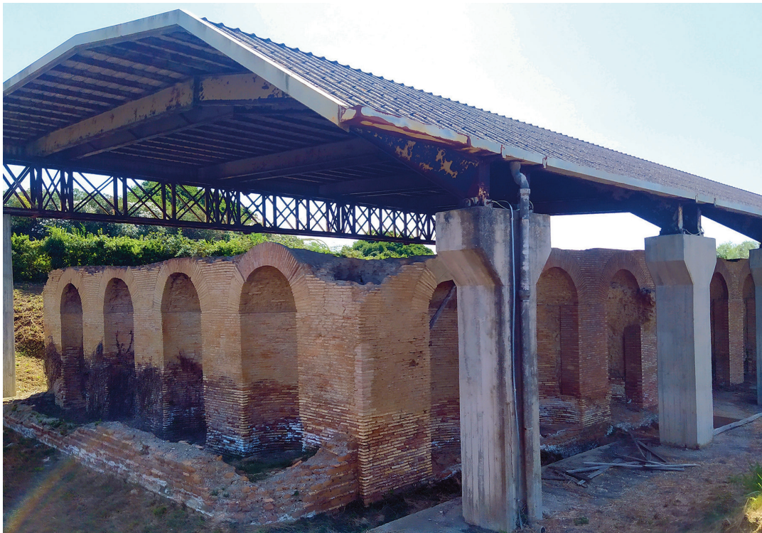
La citerne du Monte Giulio / La cisterna di Monte Giulio (M. Lo Blundo).
