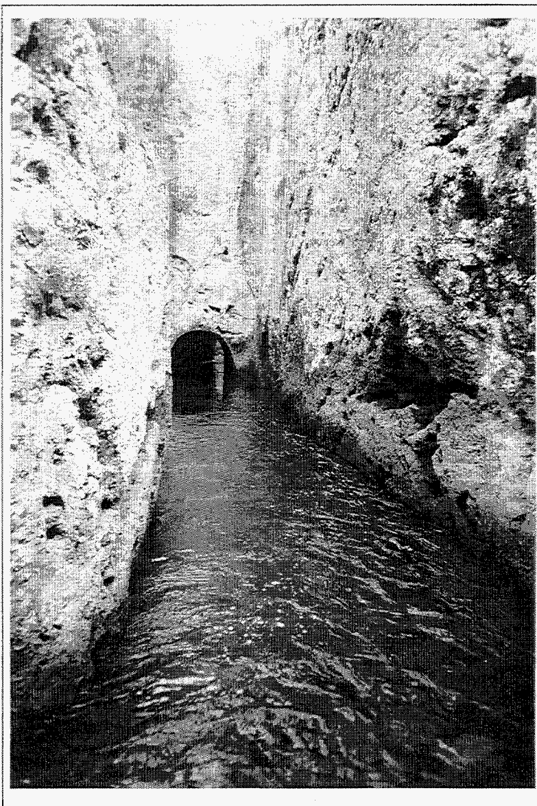
Fig. 7.9 – Portus Cosanus (Ansedonia): la "Tagliata etrusca" dal lato nord; vista del tunnel entro cui defluiva il canale di drenaggio della Laguna di Burano.
