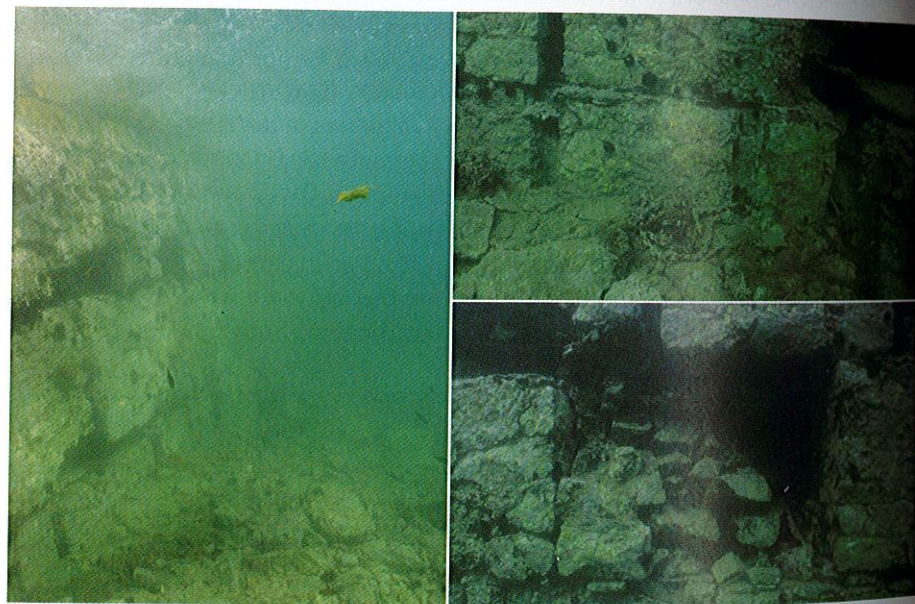
Εικ. 5. Ο τρόπος κατασκευής της προβλήτας στο παλαιό λιμάνι της Σκιάθου.
