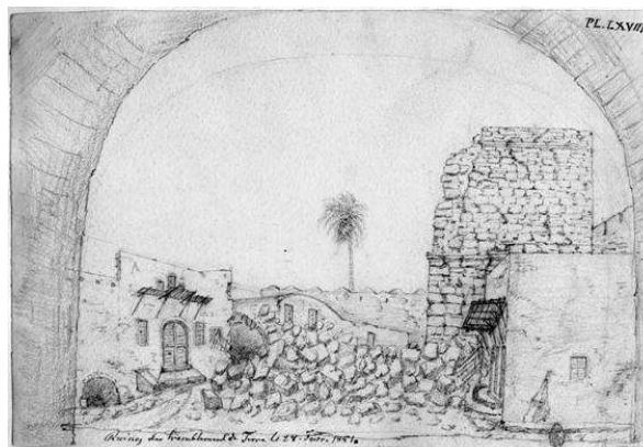
16β. Εικόνα της κατάρρευσης του 3 ου ορόφου του πύργου του λιμανιού με τα οικίσματα του Naillac, κατά τον σεισμό του 1852.
