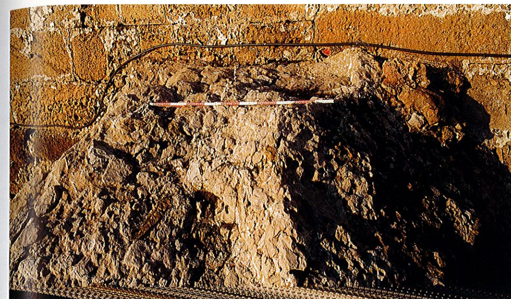
Abb. 16. Εικ. 16. Abb. 15 u. 16. Kunstfelsen bei C und Oberseite eines Kunstfelsens bei B mit hergerichteter Lagerfläche für die Aufnahme weiterer Blöcke. Εικ. 15 κ. 16. Τεχνητοί βράχοι στο C και άνω προλειασμένη επιφάνεια βράχου στο B για την υποδοχή κι άλλων ογκόλιθων.
