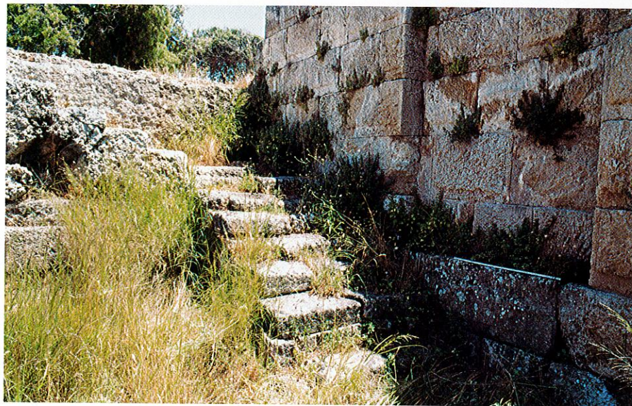
Abb. 3 u. 4. Roter (oben), hydraulischer Putz an den Mauern und dem Sockel beweist, dass es sich um ein sehr großes, künstliches Wasserbecken handelt. Im Blick von Südwesten ist unten am Sockel ein Fußprofil sichtbar, mit dem das über dem Wasser aufgehende Mauerwerk des Sockels begann.
