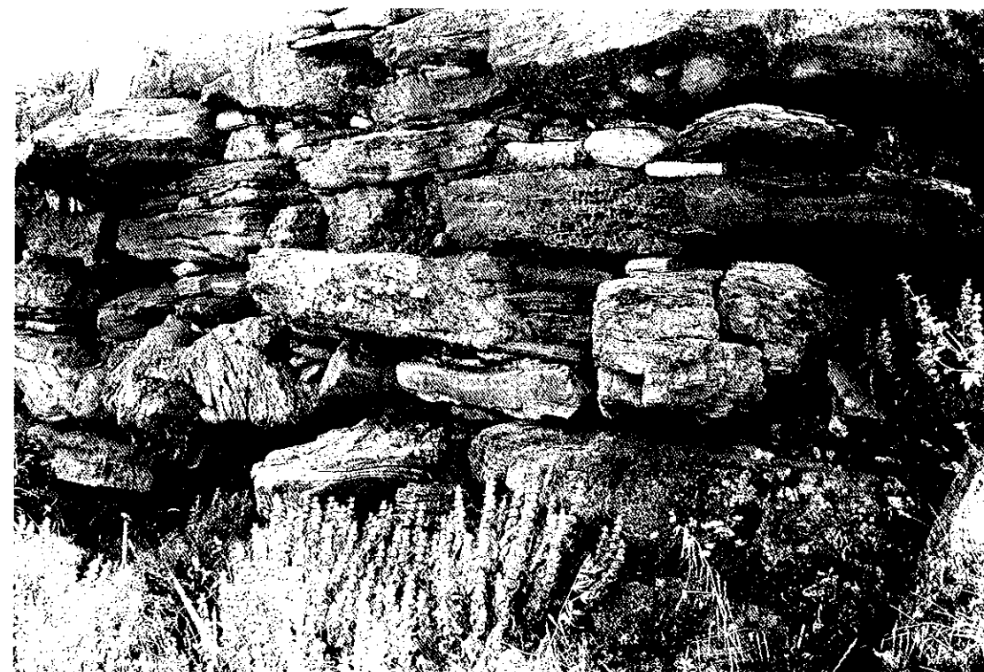
Εικ. 15. "Εξέχουσα ογκώδης τοιχοποιία" στα τείχη ακροπόλεως Ποιήσσας.
