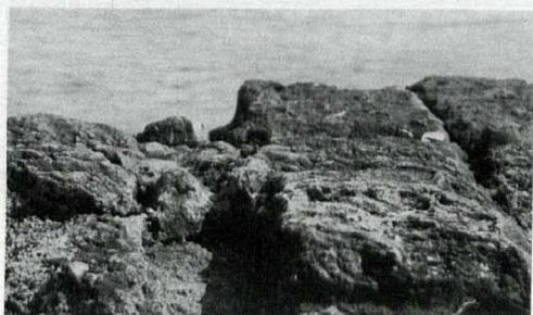
Abb. 47a und b. Südkai, Mörtelfüllung einer Bettungsrinne unter einem Quaderblock (a) und ohne überdeckenden Quaderblock (b)
