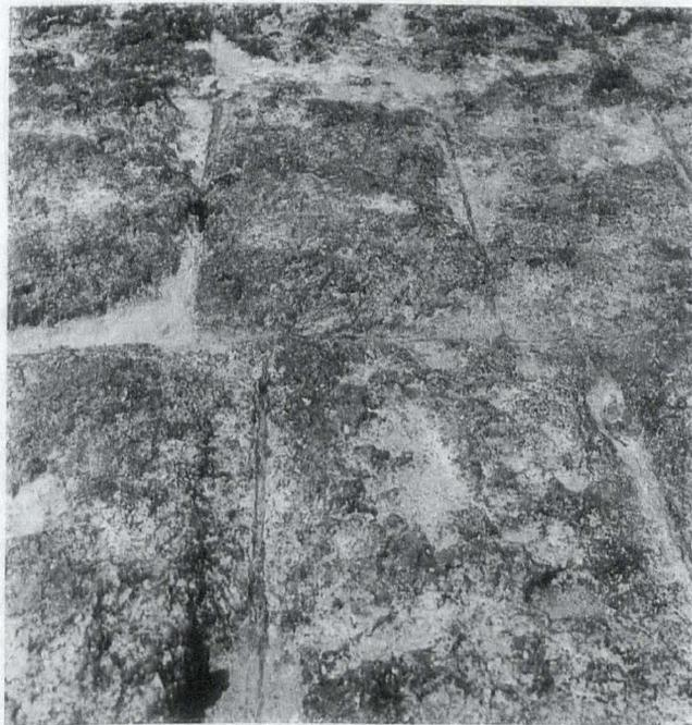
Abb. 10. Nordmole, VI. Quermauer, Quader mit Fugenmörtel
