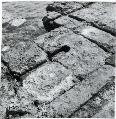
Abb. 48. Südkai, Verbandswechsel am Quadermauerwerk der hafenseitigen Längsmauer zwischen VII. und VIII. Quermauer
