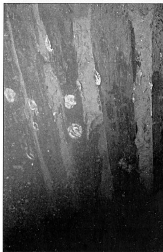
Fig. 3. Port la Nautique, disposition des madriers, non jointifs. Les marques blanches sont des coquilles d'huîtres.
