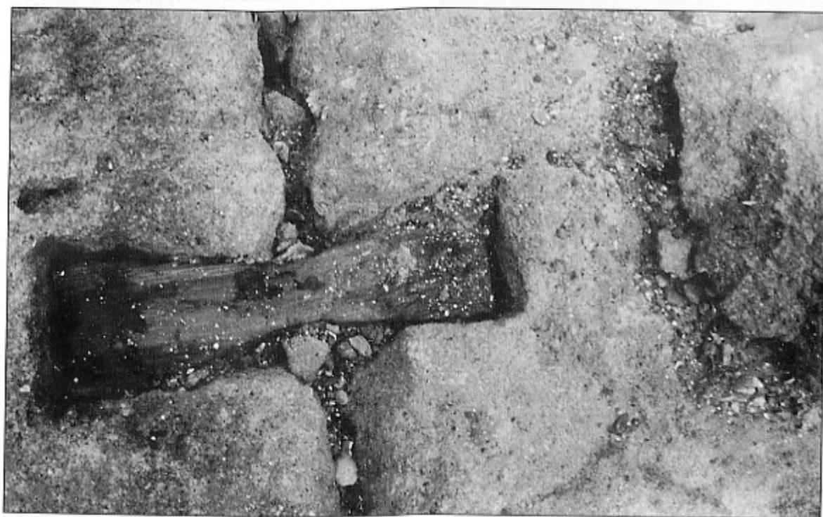
Fig. 6. Port la Nautique, clé de bois en queue d'aronde de l'assise supérieure
