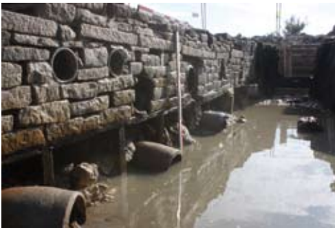
Vue du mur nord du bassin rectangulaire à abside depuis l'ouest. On distingue au fond le système de vannes à glissière © N. Carayon
