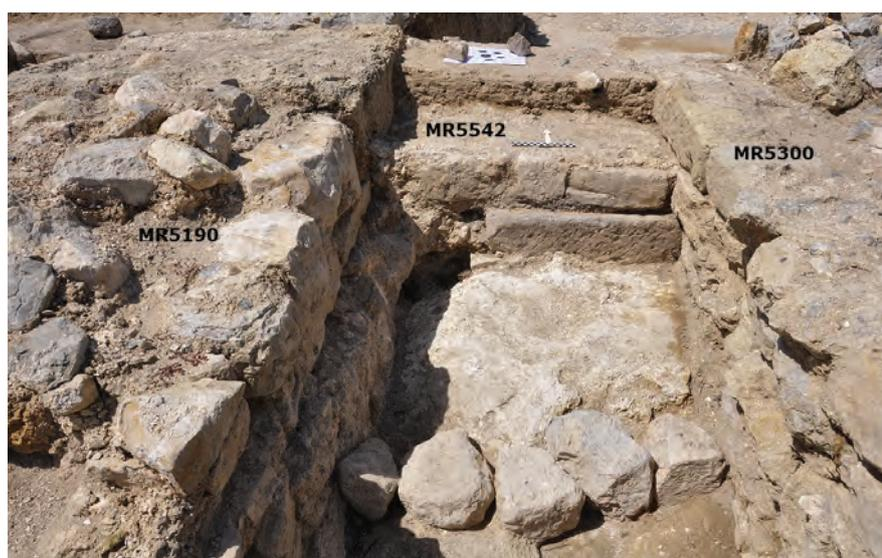
**Fig. 16 : Détail sur le parement sud de MR5542. Le bloc formant l'assise basse de ce parement s'enfonce sous MR5300 et adopte l'aspect d'une contremarche en pierre de taille. C'est lors de la mise en place de MR5300, avec lequel elle est ancrée, que l'assise haute de MR5542 a été mise en place (©V. Mathieu-CNRS).**
