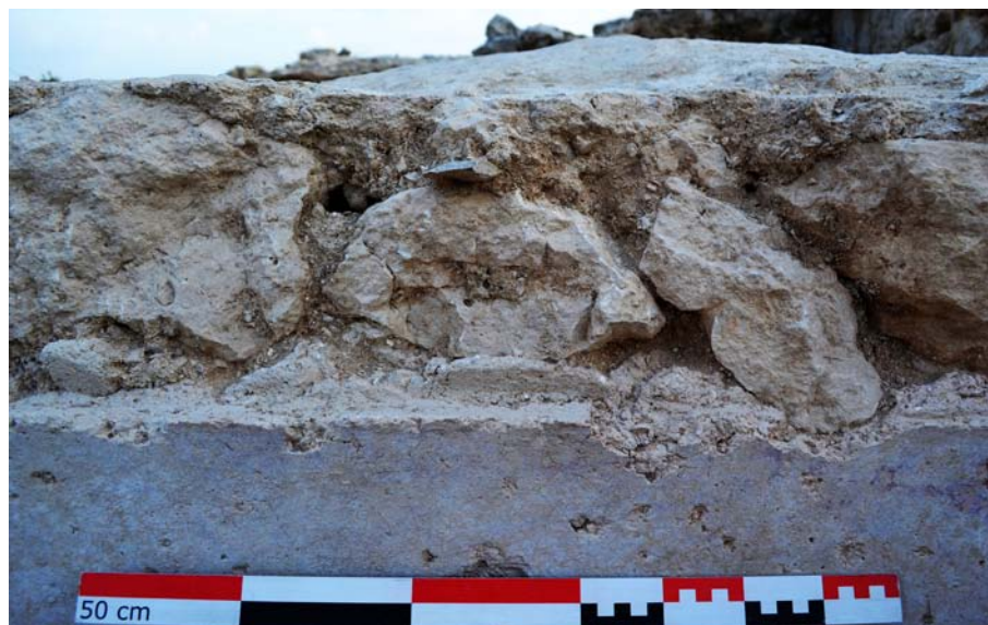
Fig. 11 : détail de la reprise d'élévation MR5203, depuis le sud (cl. G. Duperron)
