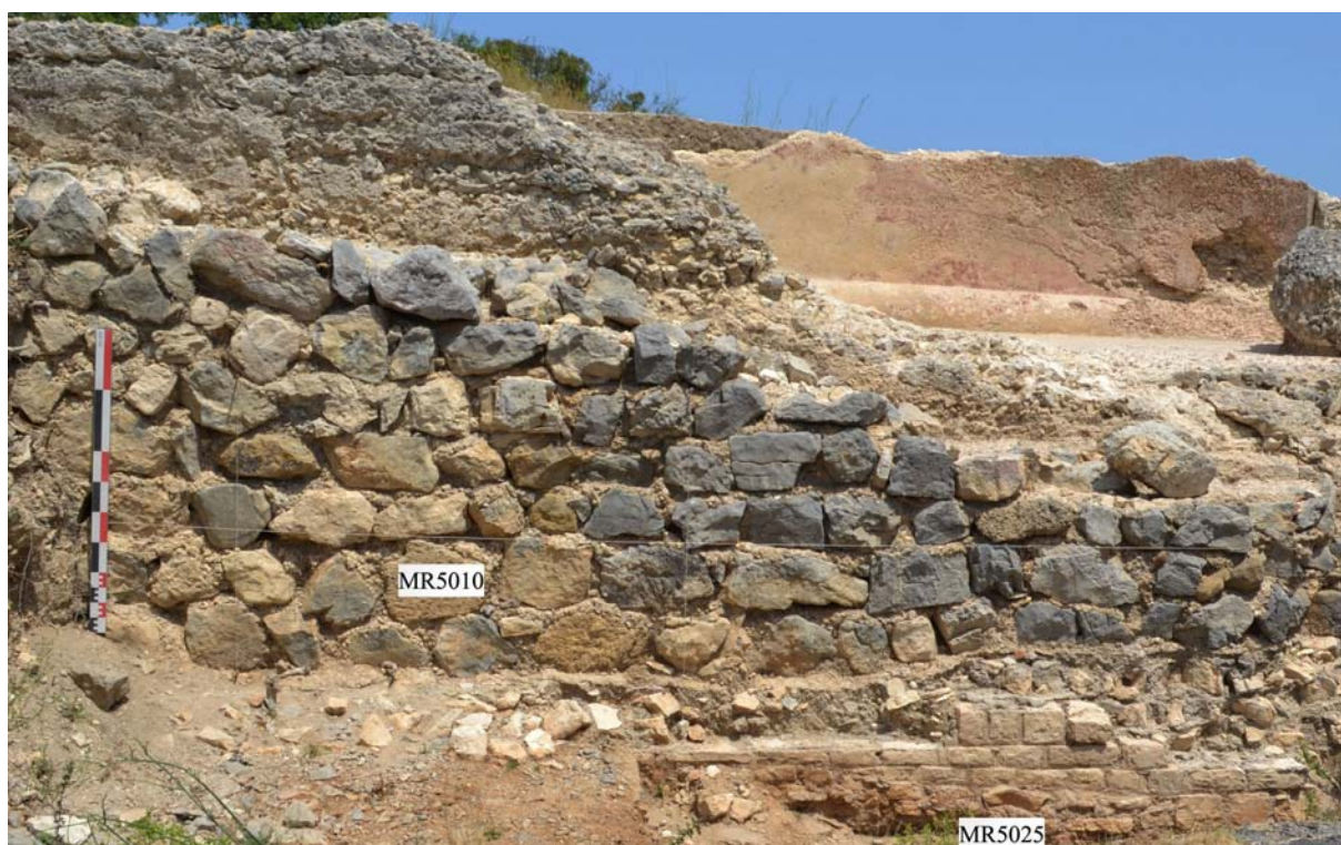
Fig. 7 : vue de MR5025 et MR5010, depuis l'ouest (cl. G. Duperron)
