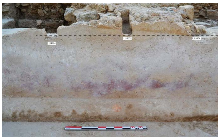
Fig. 13 : vue des saignées US5074, US5075 et US5314, depuis l'ouest (cl. G. Duperron)
