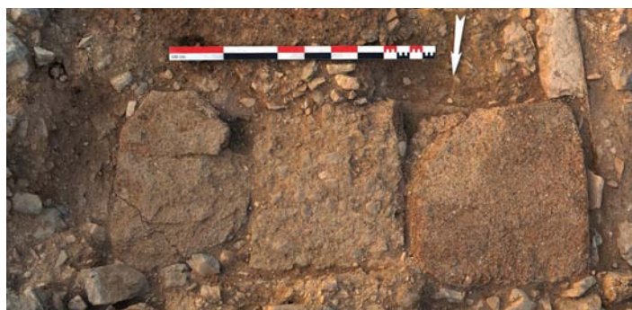
Fig. 12 : vue de la couverture SP5221, depuis le nord (Cl. G. Duperron)
