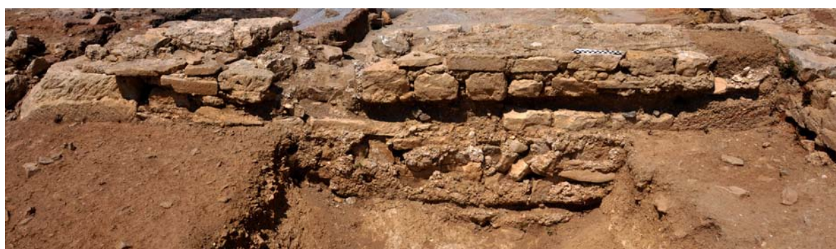
Fig. 32 : vue générale du parement oriental de MR3012 depuis l'espace 301 (cliché : V. Mathieu)
