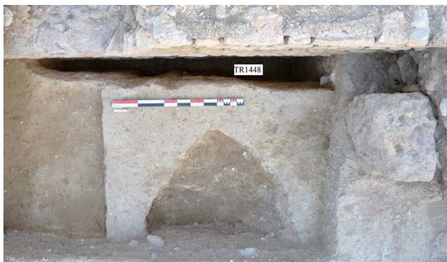
Fig. 4 : vue de la tranchée de fondation TR1448 de MR1119 depuis l'est (cl. G. Duperron)
