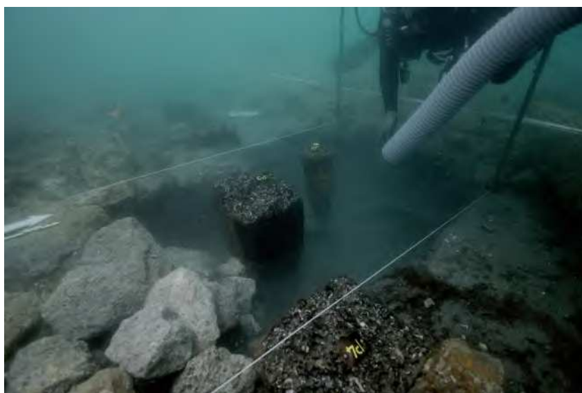
▲ Figure 45 Aménagements de La Marronède centrale, alignement de pieux en chêne en cours de sondage (cl. P. Groscaux).
