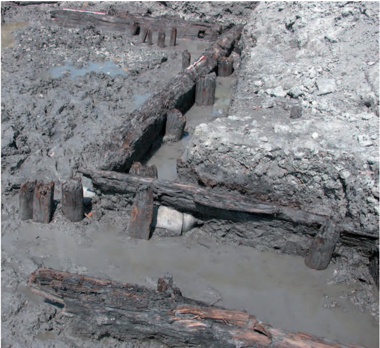
Fig. 4 : Ossature en bois des caissons E1 et E2. Au premier plan, le canal E3 (cliché : F. Marty).
