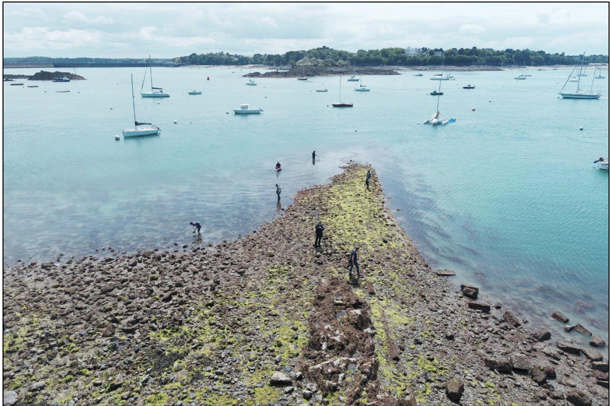
Figure 6 – Vue du drone de l'ouvrage des Corbières.
