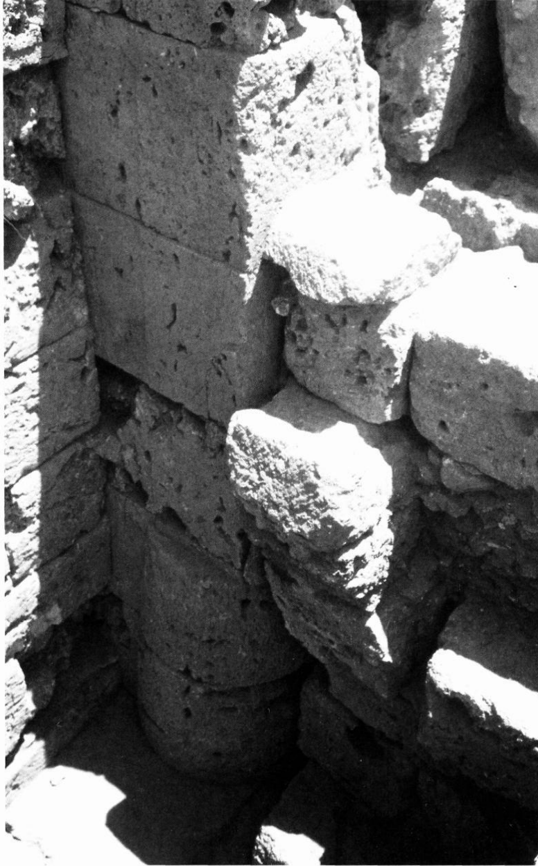
FIG. 28. — Le montant nord de la porte sud, vu de l'extérieur de l'enceinte ; en bas, le chasse-roues de l'ouverture primitive ; les blocs dans l'embrasure correspondent à deux exhaussements successifs du seuil (photo A. Laronde).
