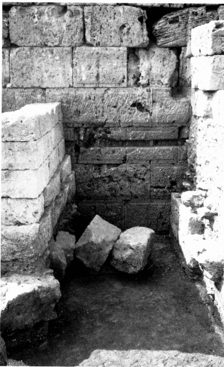
FIG. 27. — L'embrasure de la porte sud et, au fond, le mur septentrional de la tour XII avec l'encastrement de la barre servant à bloquer le vantaux de la porte. Sur le sol, blocs du couronnement de la tour dans la position où ils furent retrouvés ; niveau du sol au début du 1 er siècle av. J.-C. (photo A. Laronde).
