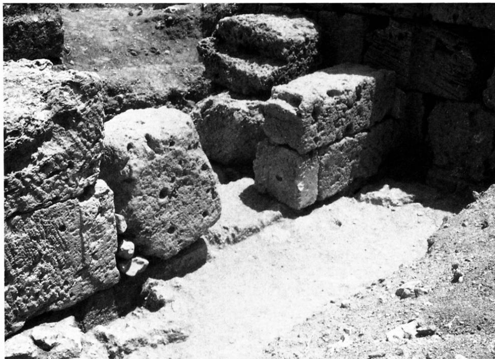
FIG. 34. — La porte sud de la ville réduite à l'état de poterne, état au début des fouilles de la Mission française (photo A. Laronde).
