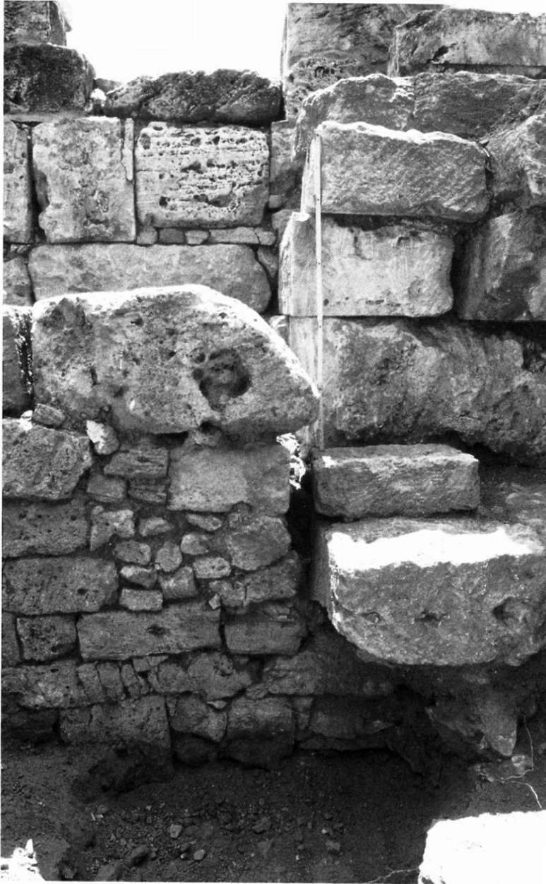
FIG. 22. — Mur de refend est-ouest du grand édifice hellénistique avec, au fond, le soubassement de la colonnade sud de l'église orientale (photo A. Laronde).
