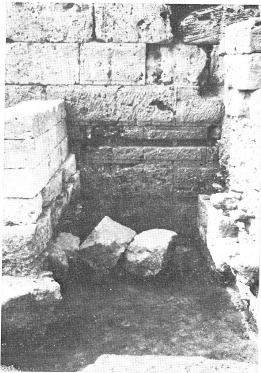
FIG. 8. — L'arrière-cour de la tour XII, entre la construction tardive à gauche et l'embrasure de la porte méridionale à droite ; au fond, le mur de gorge de la tour XII avec l'encoche destinée à recevoir la barre de blocage des vantaux de la porte ; le sol laissé au niveau du début du 1 er siècle av. J.-C. porte les blocs tombés alors du couronnement de la tour ; on observe dans l'embrasure de la porte le muret construit à la même époque (photo A. Laronde).
