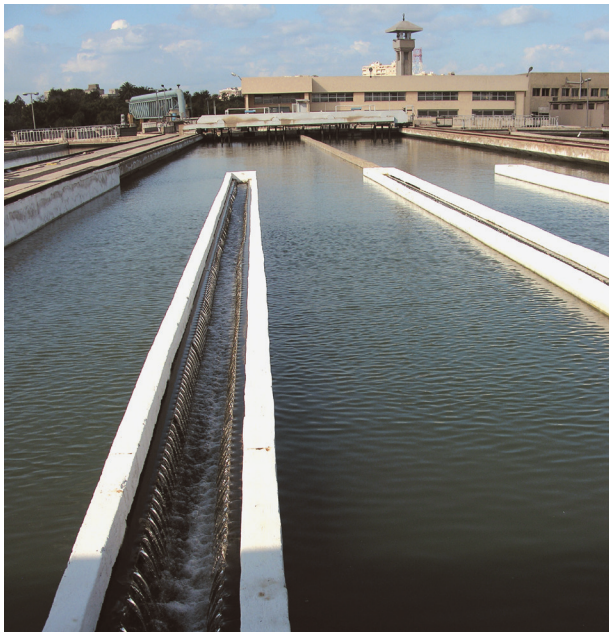
◀ 28. Station d'épuration de Nouzha située près de l'aéroport à Alexandrie.
