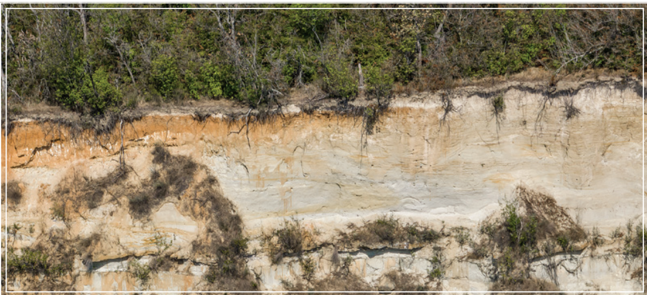
Fig. I. 2. 5. Landslide at Cape Killik Свлачище при нос Куллик
