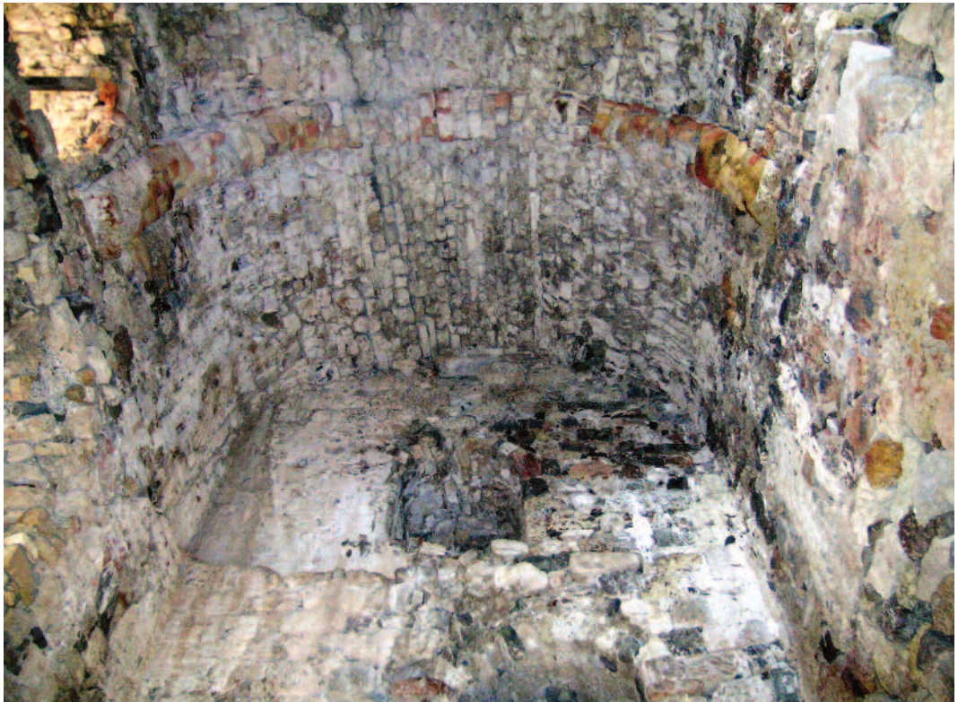
Fig. 13: Intérieur de la tour, avec la voûte en berceau du niveau supérieur (P. Androudis, 2006).
