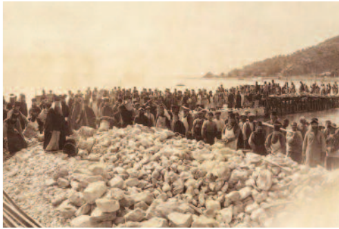
Εικ. 7: Ἡ κατασκευὴ τοῦ λιμένος τῆς Μονῆς τοῦ Ἁγίου Παντελεήμονος. (φωτ. ἀρχῶν 20οῦ αἰ.).
