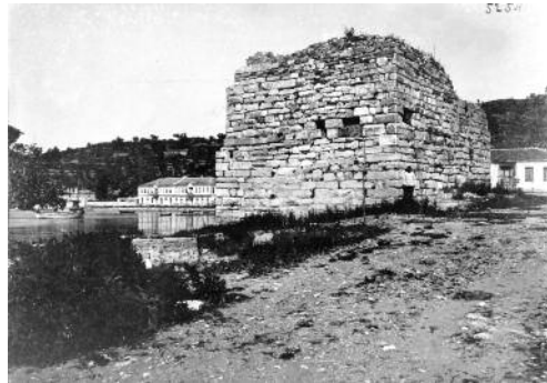
Εικ. 12: Θάσος Μαρμαρολιμήν. Ο πύργος του Ιωάννη πριν την κατεδάφισή του. (Φωτογραφικό Αρχείο Γαλλικής Σχολής Αθηνών).
