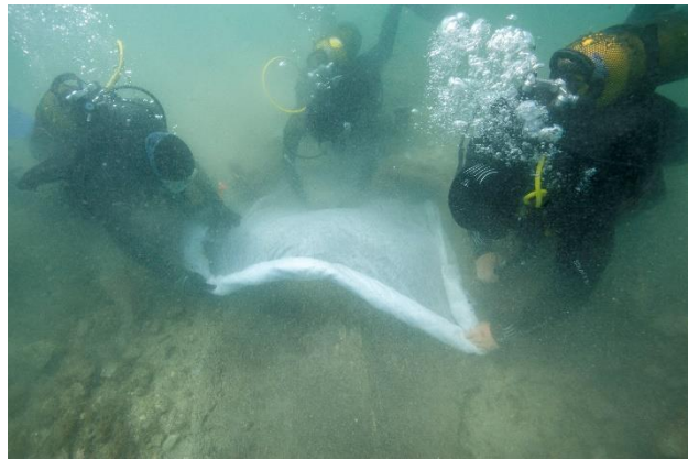
Fig. 8 : Mise en place du géo-textile (© L. Roux, Centre Camille Jullian, AMU-CNRS)
