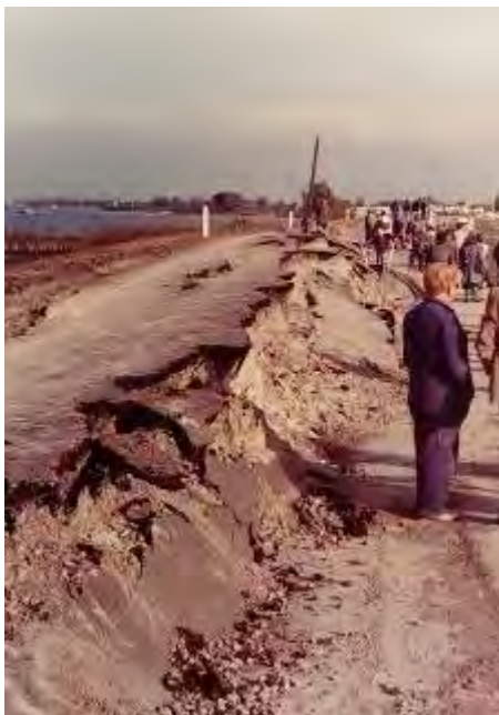
Figuur 1-25: Afschuiving van de dijk bij Streefkerk in 1989 (bron: RWS-DWW).
