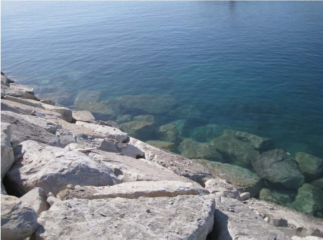
Photo no. 1 – Sous couche de la digue Nord côté interne - La ligne du talus de la sous couche ne semble pas régulière.
