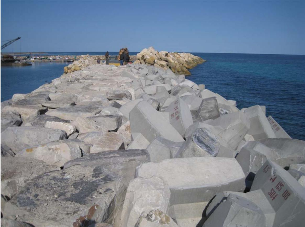
Photo no. 9 - Digue Nord - Blocage de la dernière ligne de blocs ACCROPODE™ par des enrochements
