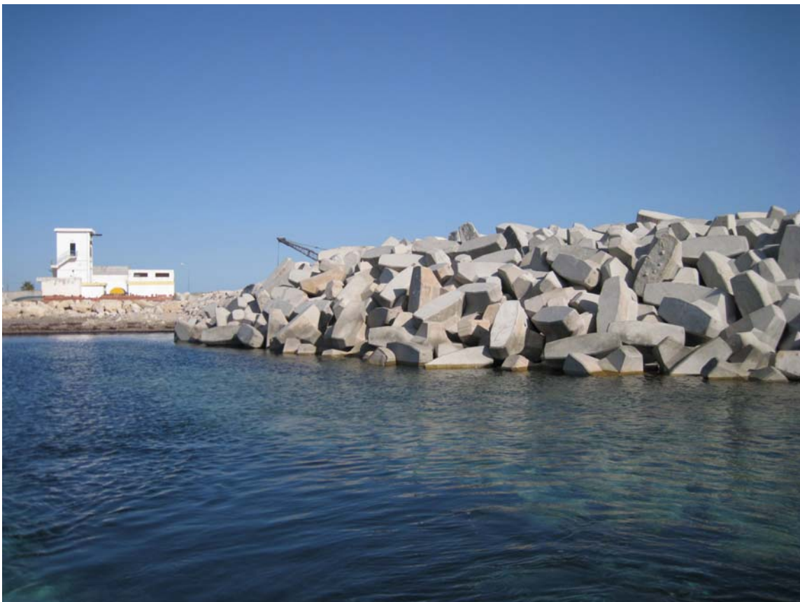
Photo No. 2 - Digue Sud - Vue de la mer sur la carapace des blocs ACCROPODE™
