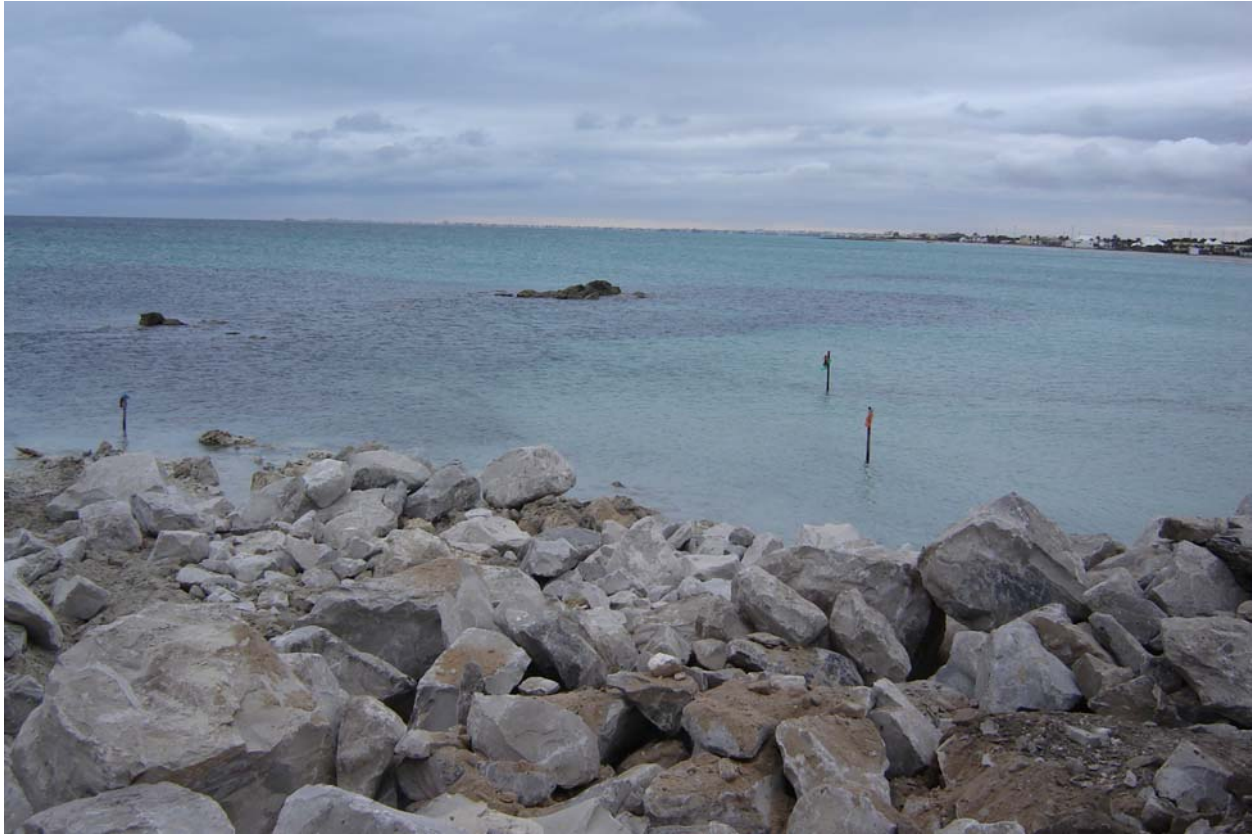
Photo N° 13 : Enracinement de l'épi Sud
