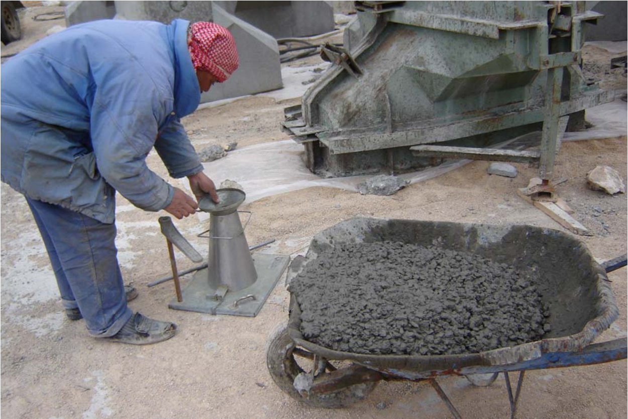
Photo N° 5 : Mesure de l'affaissement du béton
