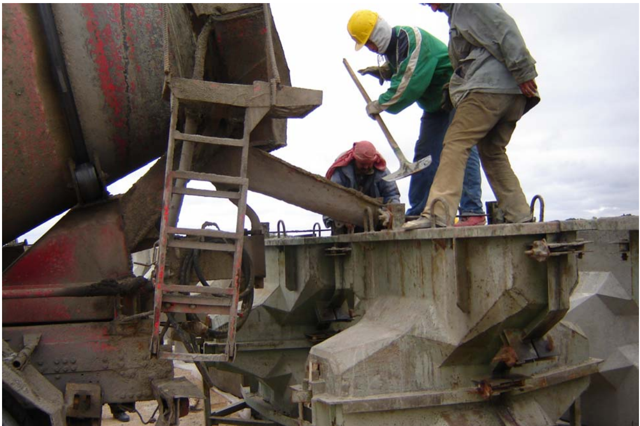
Photo N° 4 : Coulage du béton (bloc de 1.5 m3)
