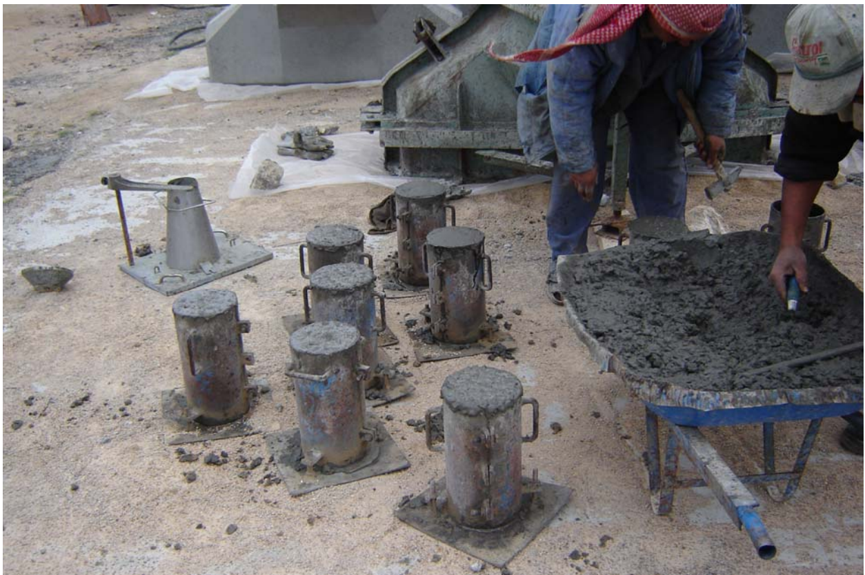
Photo N° 6 : Prélèvement d'échantillons de béton
