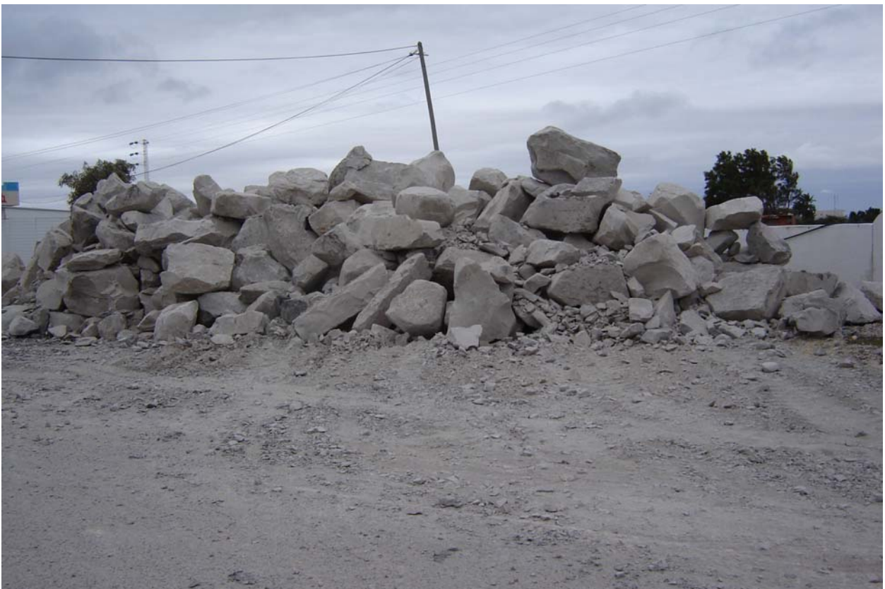
Photo N° 16 : Aire de stockage des enrochements avant triage
