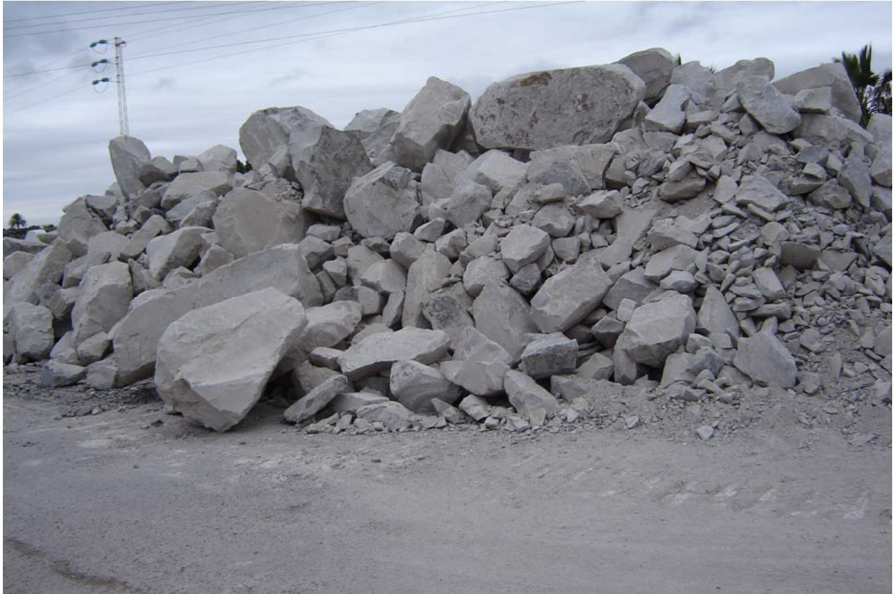
Photo N° 15 : Aire de stockage des enrochements avant triage
