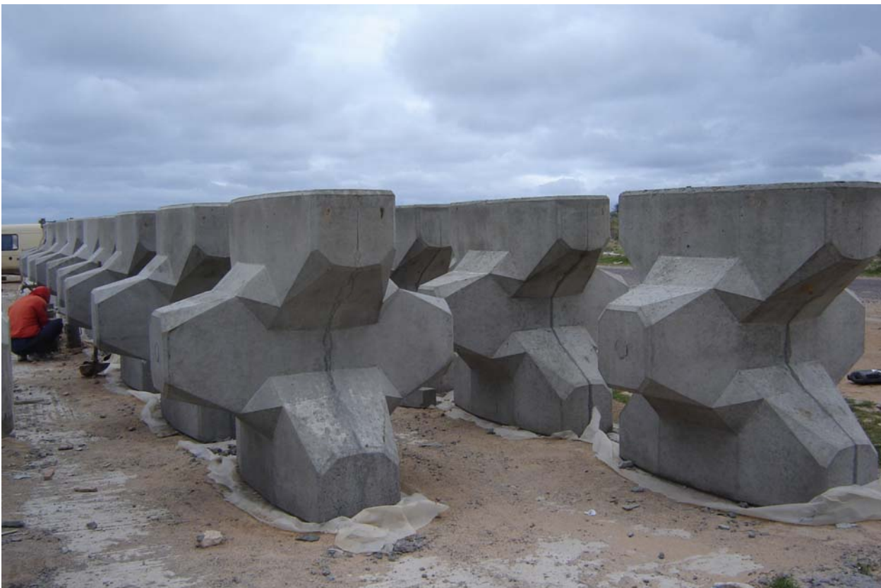
Photo N° 8 : Aire de bétonnage
