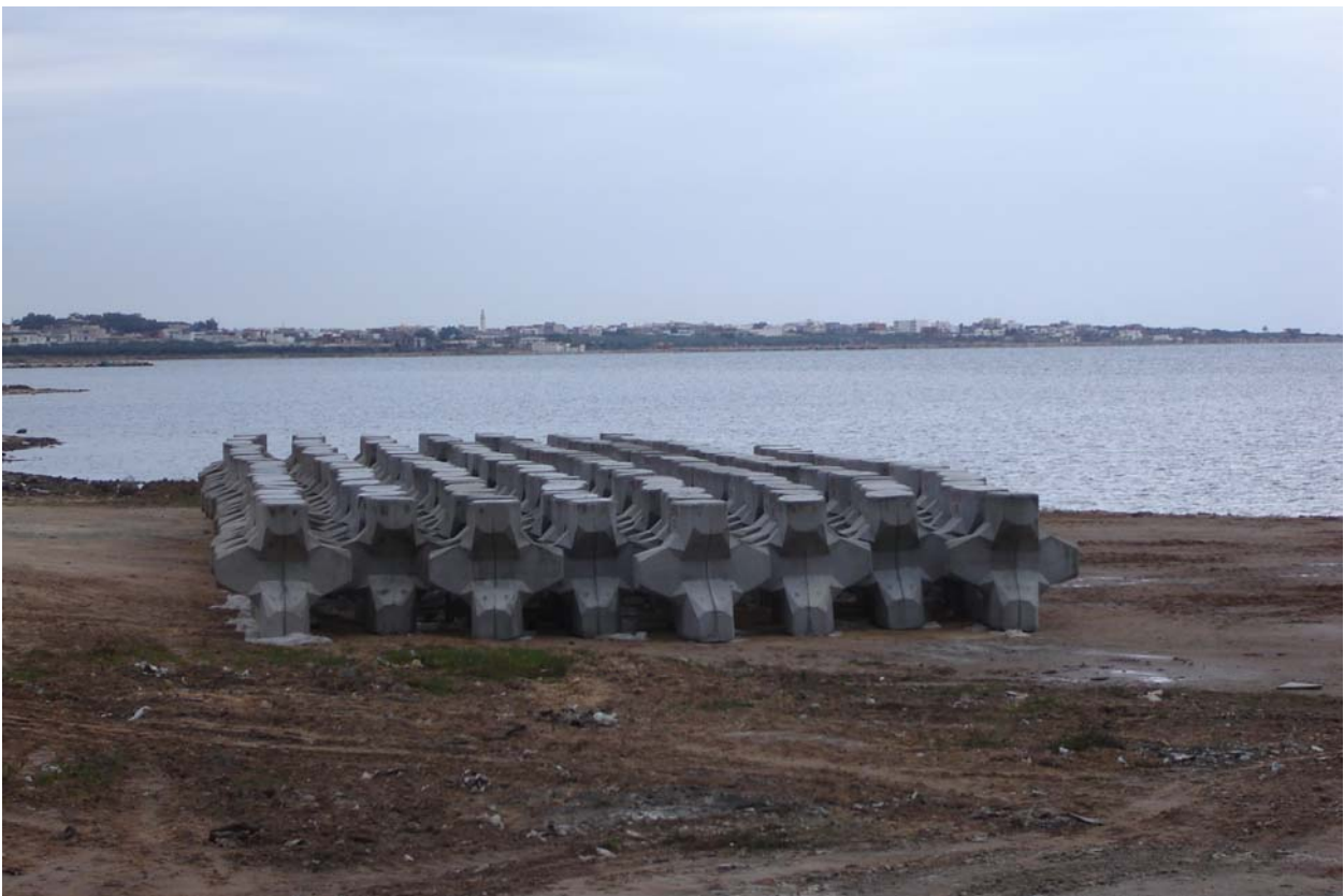
Photo N° 12 : Aire de stockage
