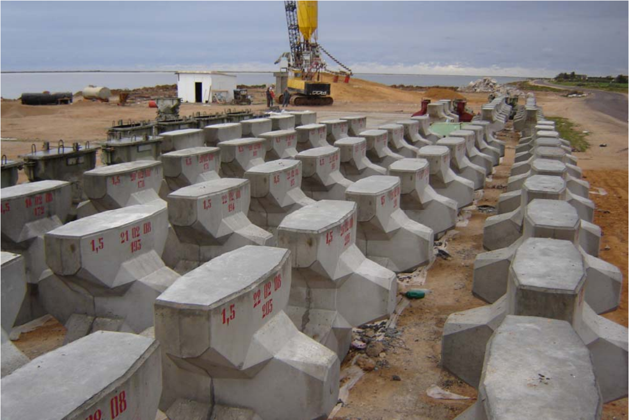
Photo N° 9 : Aire de bétonnage
