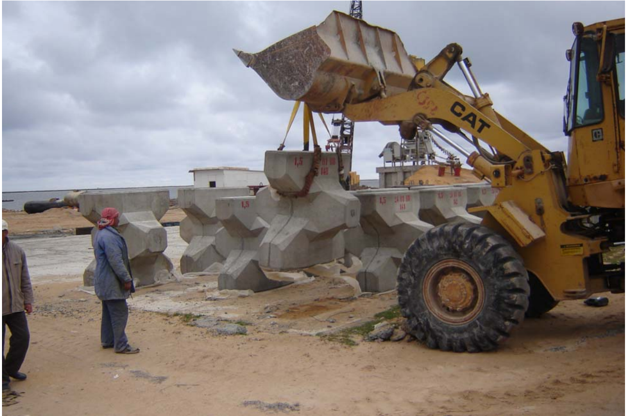
Photo N° 11 : Manutention et stockage des blocs
