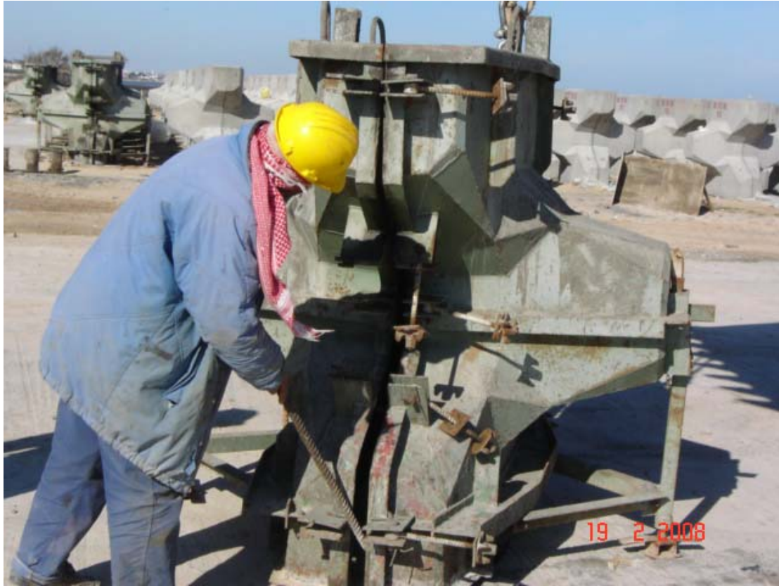
Photo N° 7 : Décoffrage des blocs ACCROPODE™ de 1.5 m3
