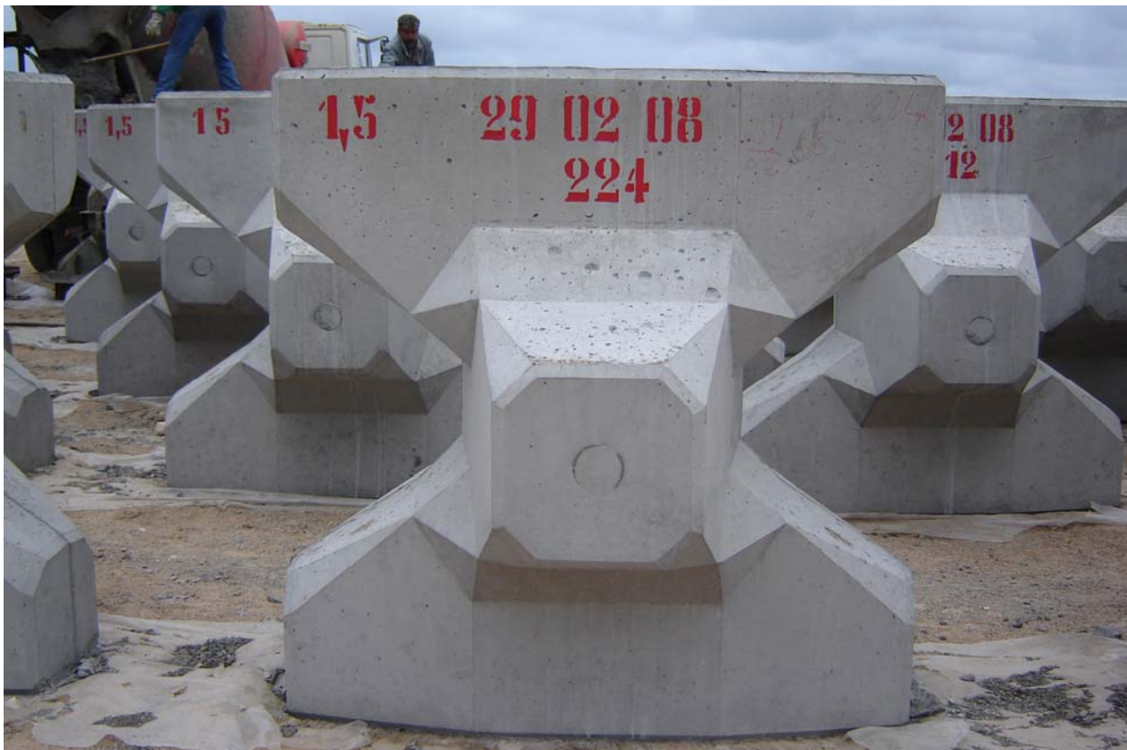
Photo N° 10 : Marquage des blocs ACCROPODE™
