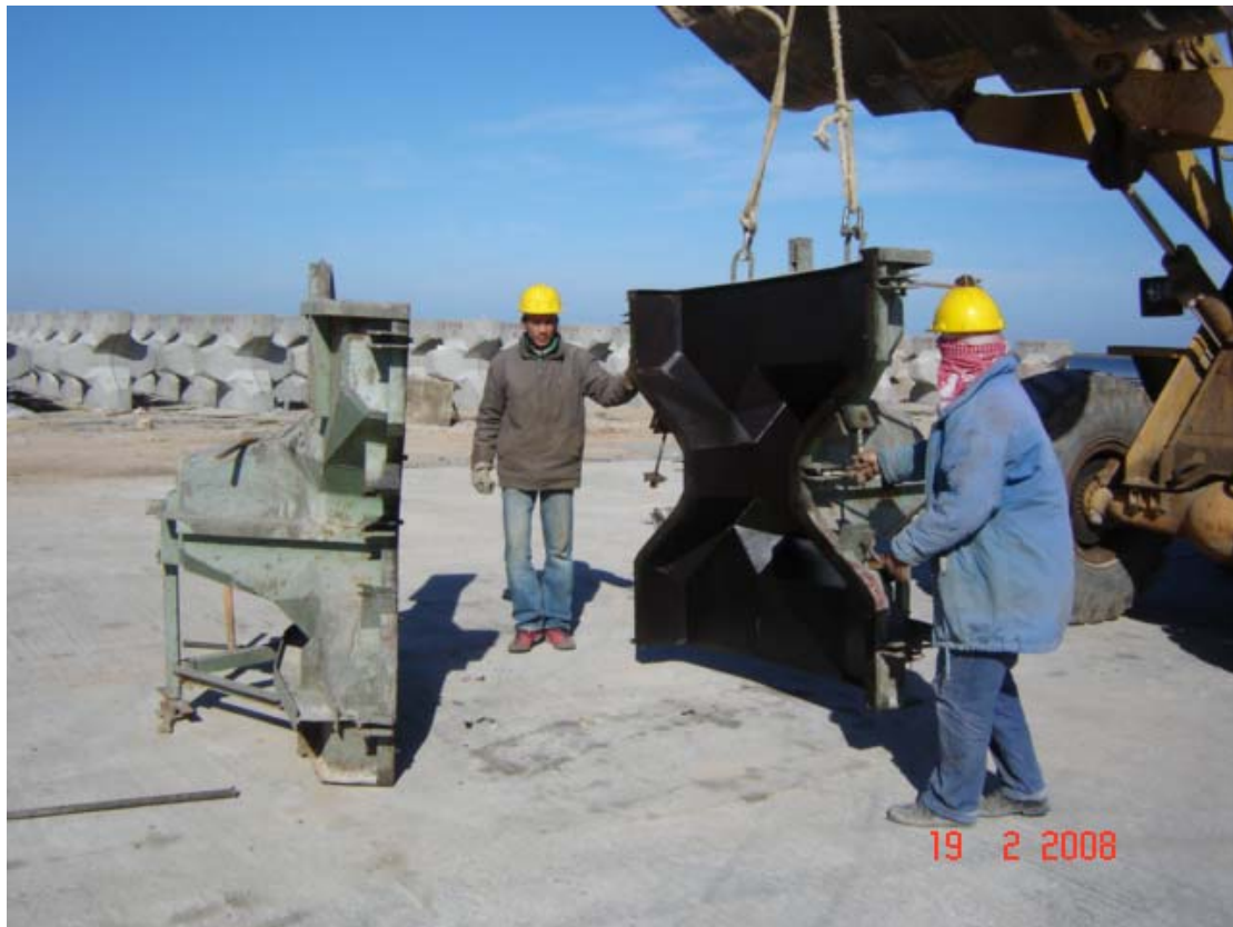
Photo N° 1 : Coffrage de 1.5 m3
