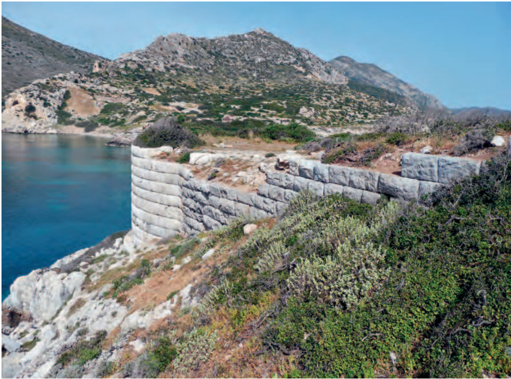
Abb. 11 Knidos. Südlicher Rundturm der Hafenbefestigung mit anschließender Kurtine. Ansicht von Südwesten (F. Pirson)
