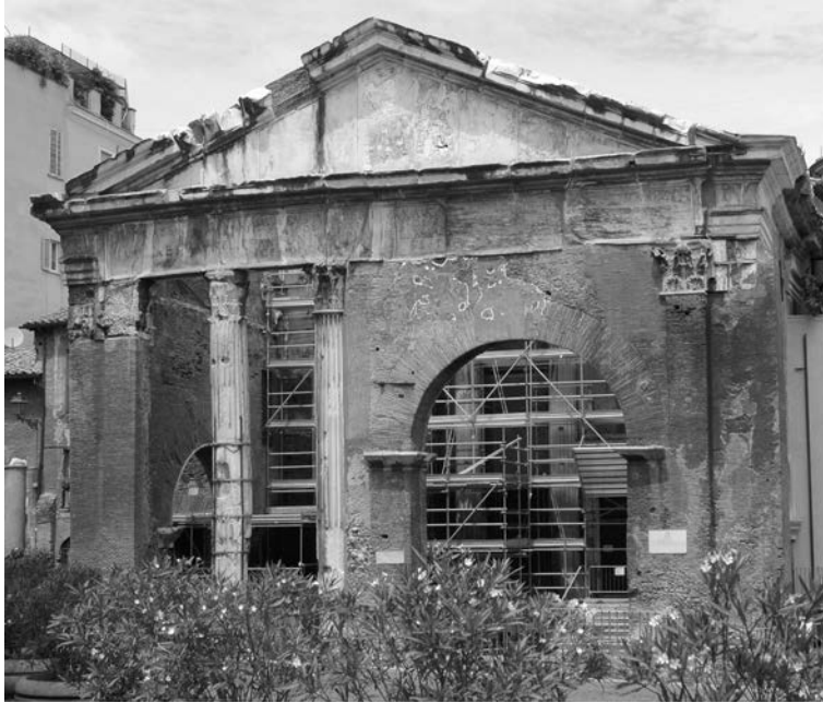
Fig. 62 – Fronte del pronao d'ingresso al Portico di Ottavia.
