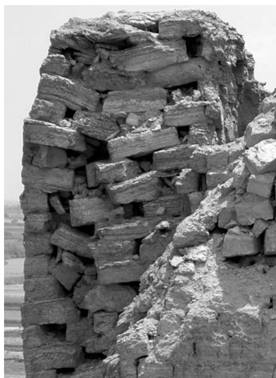
Fig. 9 – Anatolia, Jerade, schiacciamento dell'arco per allontanamento dei piedritti con dissesto della struttura soprastante.
