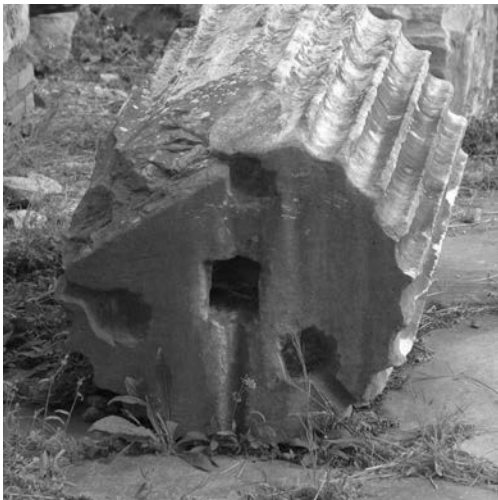
Fig. 51 – Foro Romano, rocchio di colonna con tracce di doppio intervento, I fase perno centrale, II fase tre perni periferici. Il secondo intervento è certamente più efficace perché si oppone a sollecitazioni multi direzionali.
