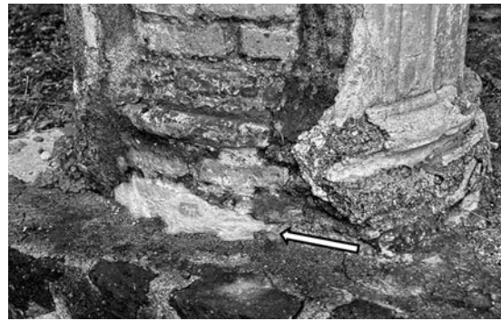
Fig. 46 – Delfi, sarcitura in piombo (con codolo anti slittamento) delle lesioni sismiche dell'opera poligonale nel santuario di Delfi.
