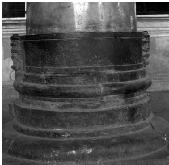
Fig. 67 – Roma, c.d. Mercati di Traiano, pilastri di appoggio delle crociere della grande aula. Si notano gli incassi per le grappe a farfalla verticali.
