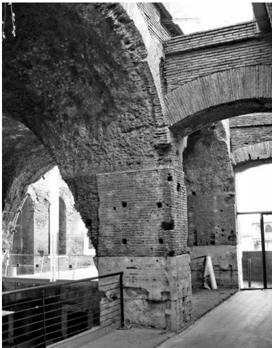
Fig. 67 – Roma, c.d. Mercati di Traiano, pilastri di appoggio delle crociere della grande aula. Si notano gli incassi per le grappe a farfalla verticali.
