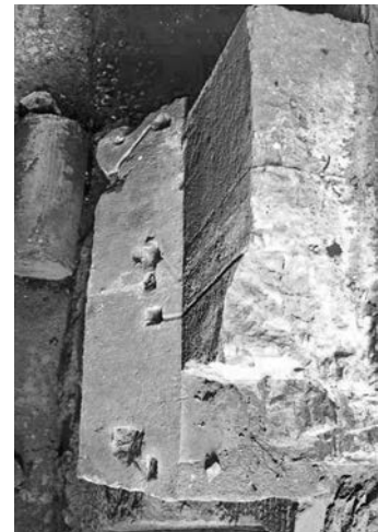
Fig. 43 – Modello dei conci di un arco con grappe e perni.
