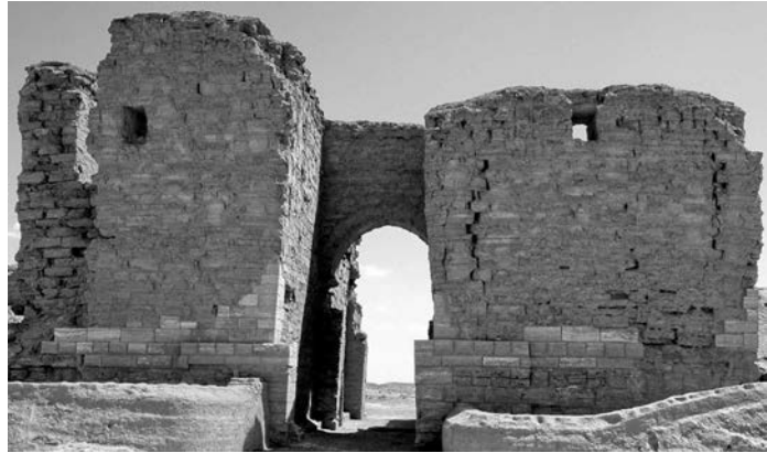
Fig. 19 – Siria, Doura Europos, la funzione di sbatacchio assolta dalla porta rispetto alle strutture laterali strapiombate perché prive di contrasto.
