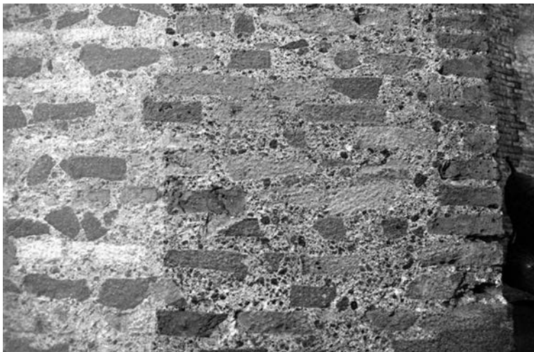
Fig. 1 – Roma, Pantheon, particolare della muratura di un pilone; a destra, evidenziata, la struttura in laterizio.
