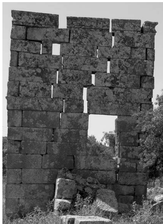
Fig. 7 – Siria, Halabye: pretorio; è evidente la maggiore entità delle lesioni con l'aumentare dell'altezza dovute all'effetto "pendolo rovescio".
