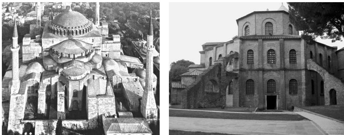
Fig. 17 – Santa Sofia di Costantinopoli, si noti il complesso contraffortamento della cupola centrale. Fig. 18 – Contrafforti lineari esterni a San Vitale di Ravenna.
