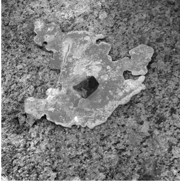
Figg. 49, 50 – Teano, teatro, (scena di età severiana), perno di bronzo di una colonna. Si noti il perno inclinato. Il piombo ne ha assecondato lo spostamento senza fratturare il blocco.
