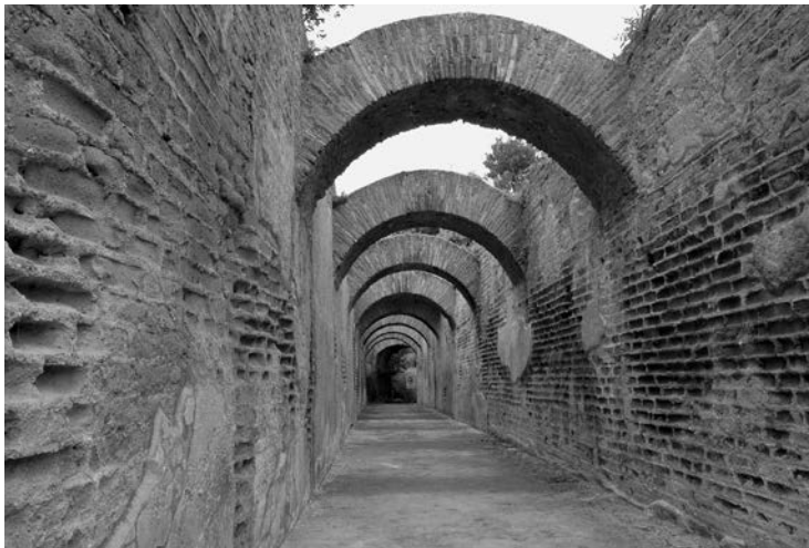
Fig. 21 – Roma, Via Nova, archi di contrasto posti forse per lo scivolamento del Palatino.
