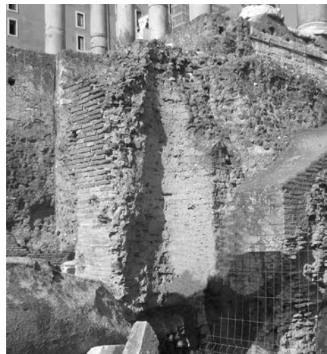
Fig. 24 – Basilica Giulia, angolo N, retro del pilone angolare che inglobò la colonna della basilica.
