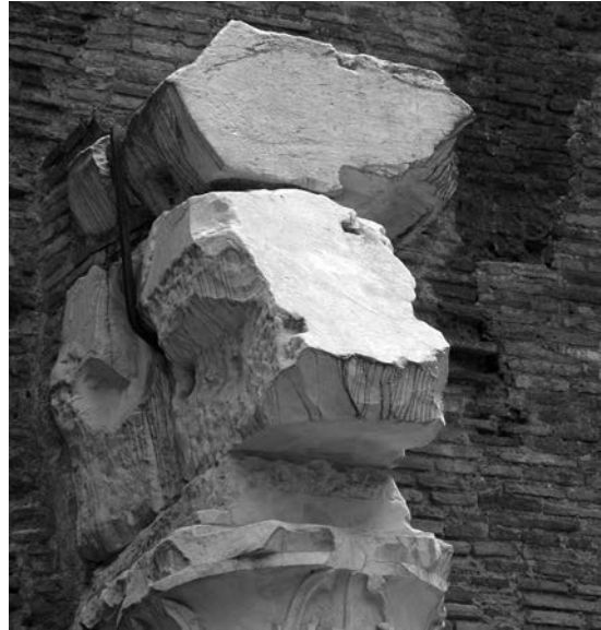
Fig. 38 – Roma, Portico di Ottavia, fase severiana, piattabanda imperniata (perni ortogonali al piano del cuneo).
