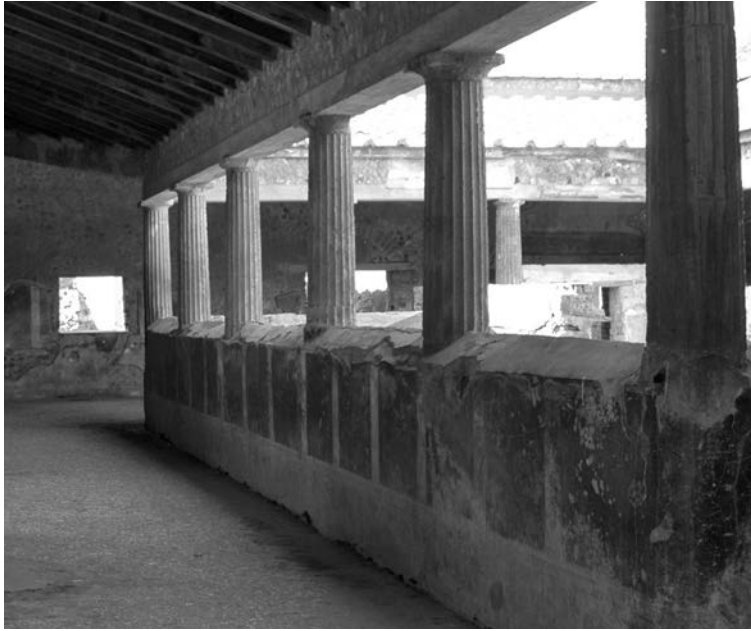
Fig. 60 – Pompei, Villa dei Misteri, colonnato chiuso dopo il terremoto del 62.
