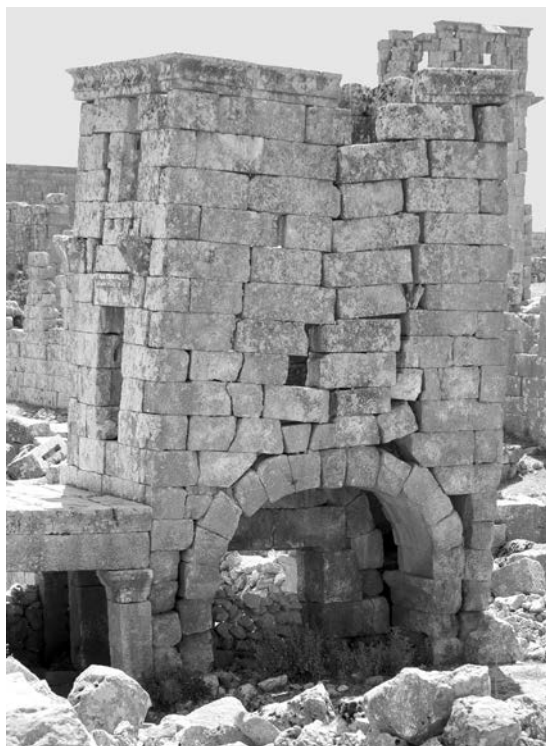
Fig. 9 – Anatolia, Jerade, schiacciamento dell'arco per allontanamento dei piedritti con dissesto della struttura soprastante.
