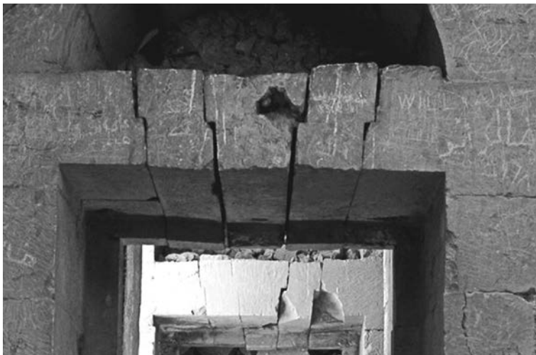
Fig. 33 – Siria, Halabye, pretorio di età bizantina. L'efficacia dei blocchi a saetta in caso di allontanamento dei piedritti per urto sismico parallelo alla fronte.
