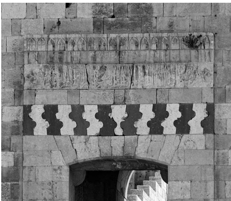
Fig. 35 – Siria, Aleppo, cittadella, piattabanda a saetta nell'architettura islamica.
