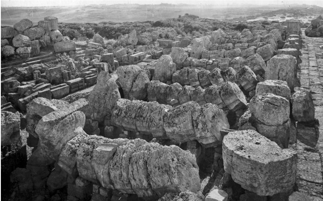
Fig. 3 – Selinunte, tempio C: l'effetto dell'urto sismico ortogonale alla peristasi del lato nord costituito da colonne di rocchi tozzi (prima dell'anastilosi).
