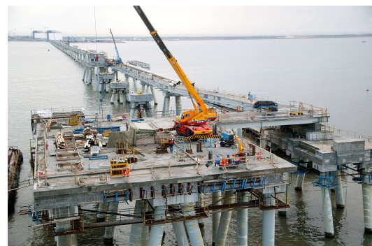
Fig. 25. Jetty at Idku (Egypt) for exporting LNG (Archirodon 2005)
