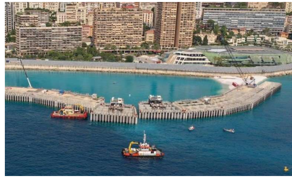
Fig. 15. 17 wave-absorbing caissons at Monaco Anse du Portier (Bouygues TP, 2019)
